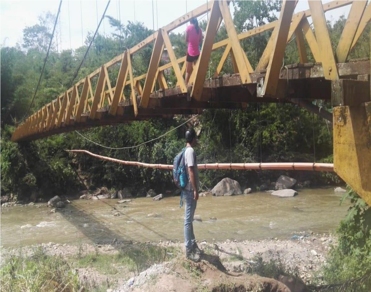
**Foto N° 10:** Se visualiza el estado de deterioro de los elementos estructurales que conforman la subestructura y superestructura del puente peatonal Shamboyacu.
