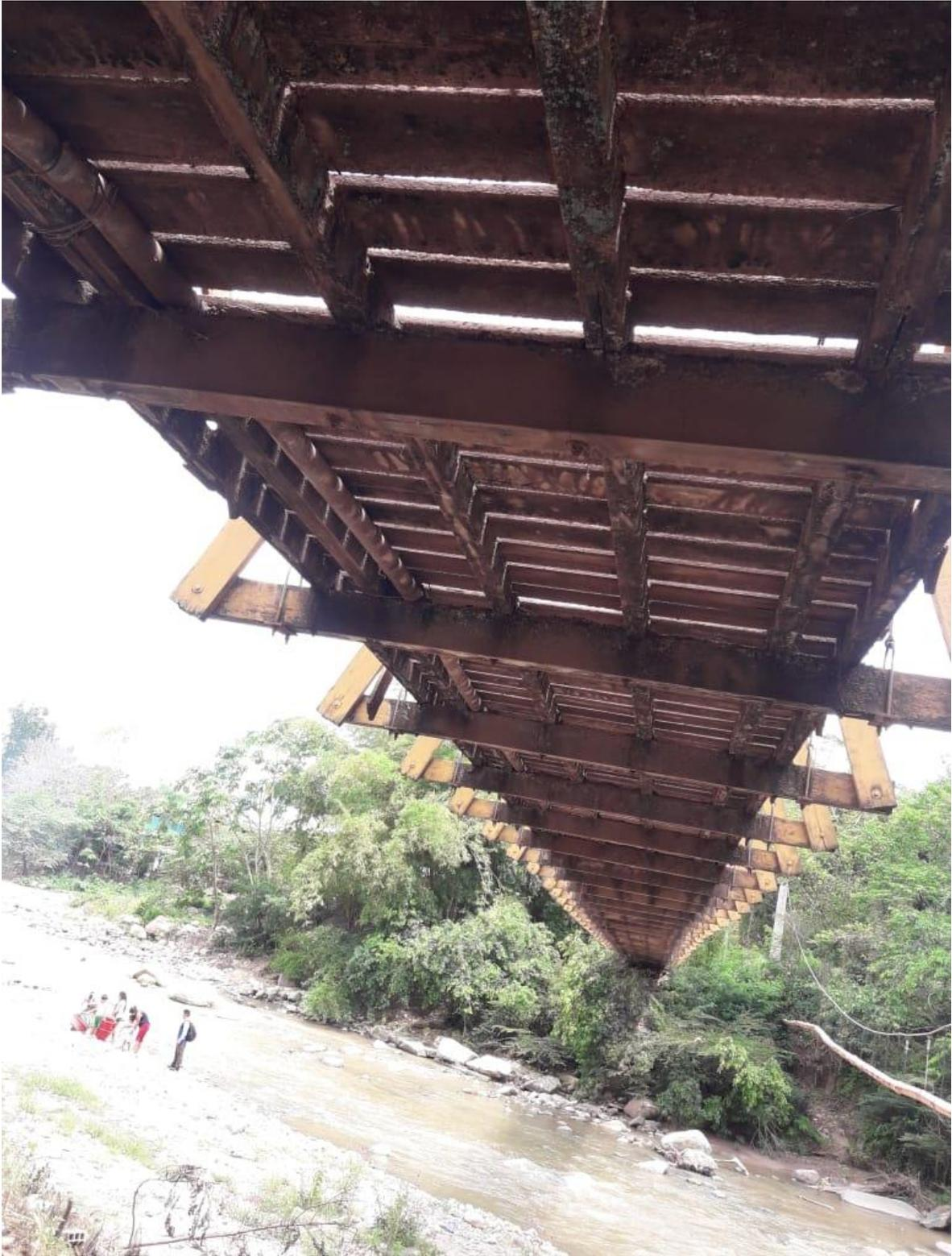
**Figura N° 14:** se ilustra en la siguiente fotografía la parte del tablero que se encuentra en un estado deteriorado por causa del mal uso y los efectos climatológicos.
