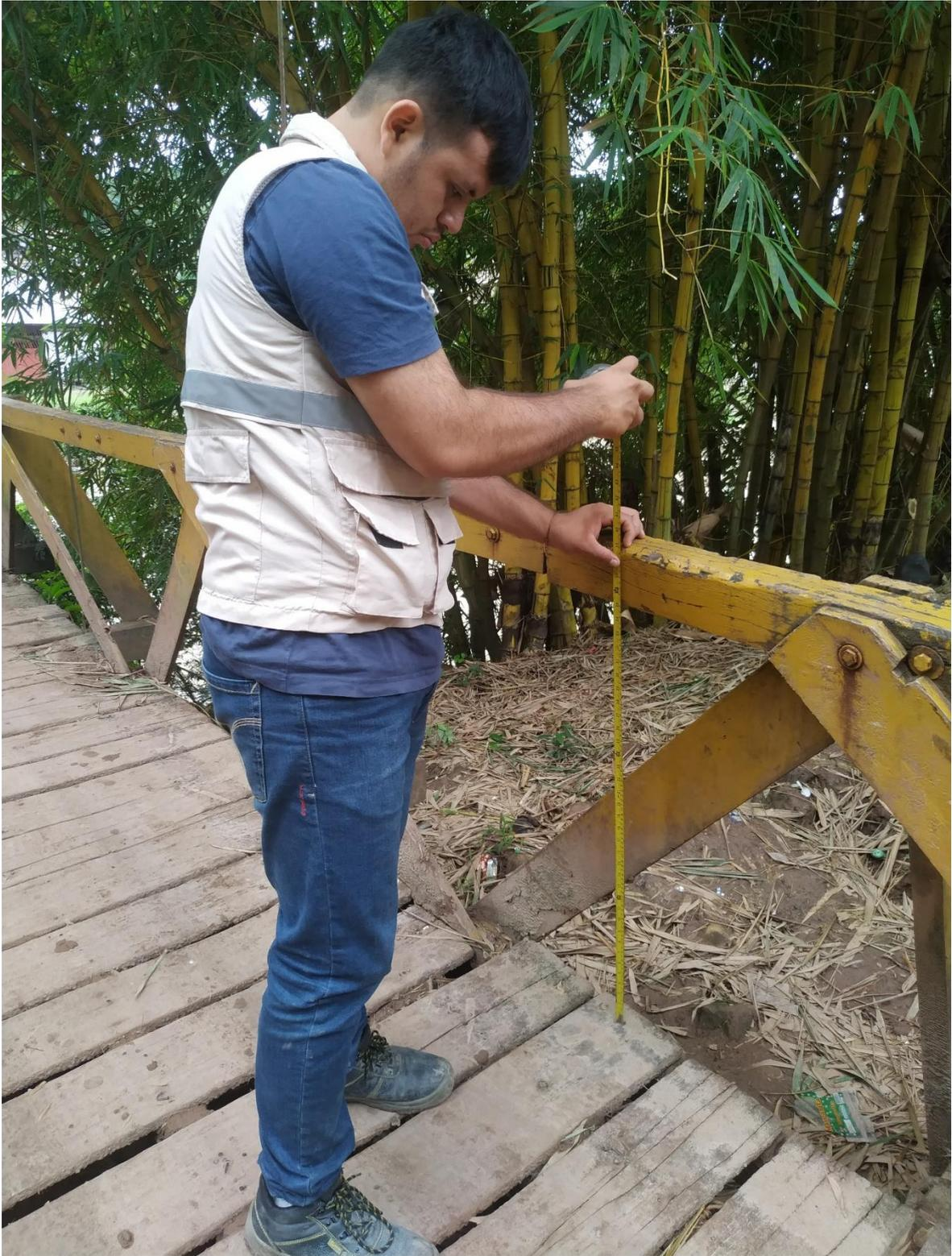
**Figura N° 12:** Se puede apreciar tomando medida de la altura de las barandas que presenta el puente peatonal Shamboyacu.
