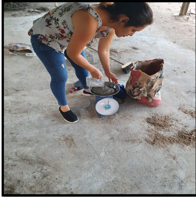
FOTO 13. Dosificación del cemento para la mezcla de las unidades de albañilería
