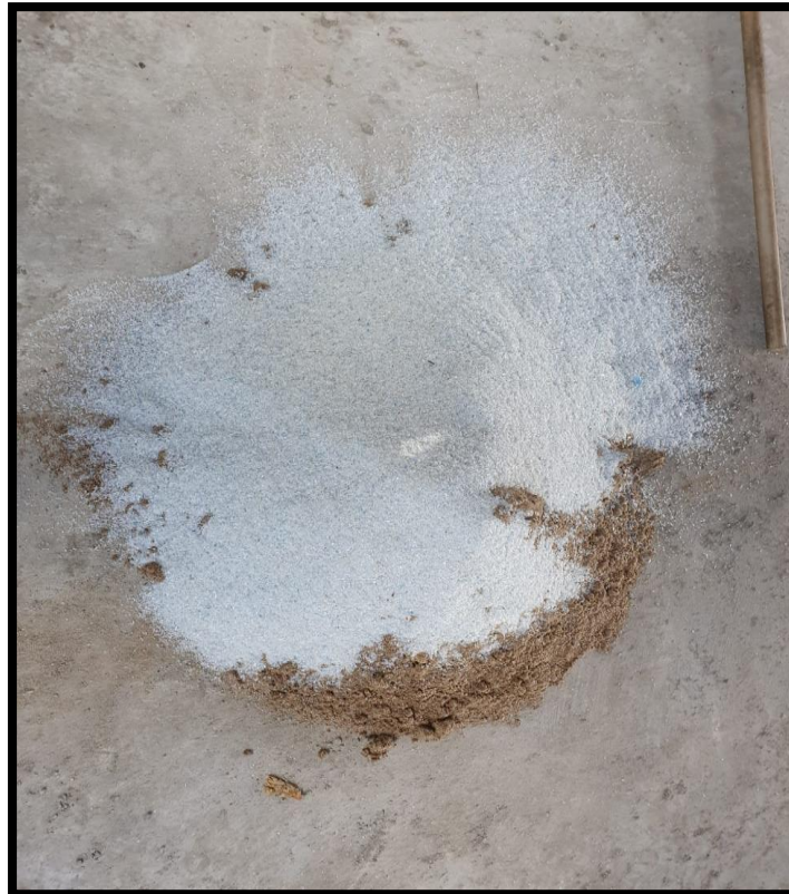
FOTO 13. Dosificación del cemento para la mezcla de las unidades de albañilería
