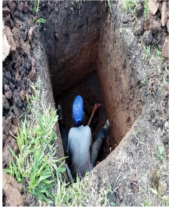
VISTA PANORÁMICA DE LAS PERFORACIONES A TAJO ABIERTO DE LAS CALICATAS N° 02, DONDE SE TOMARON LAS MUESTRAS PARA LOS ANÁLISIS Y PRUEBAS. DETERMINACIÓN DE LA HUMEDAD NATURAL “IN SITU”, DONDE SE OBSERVA AL ESTRATO SUPERIOR E INFERIOR ESTA CONFORMADO POR ARCILLA INORGÁNICA DE ALTA PLASTICIDAD.
