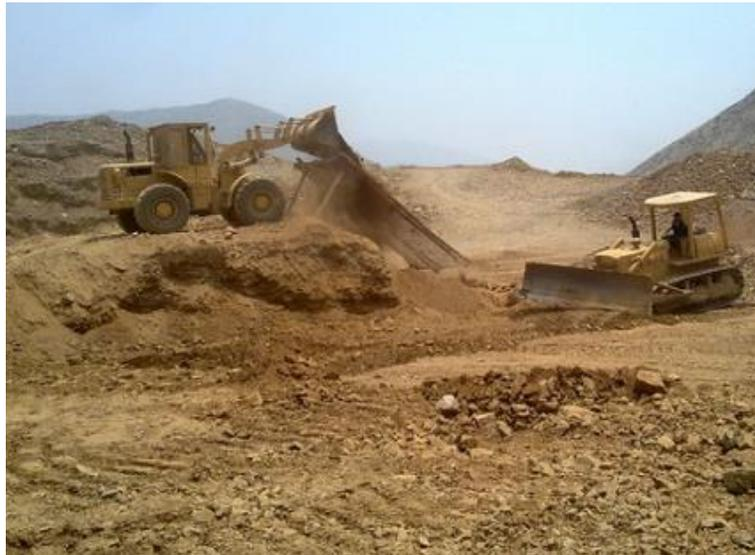
En la imagen se observa cantera de huachipa de donde se extrae el afirmado para la construcción del pavimento flexible Fuente: elaboración propia: 30/07/2018 lugar: Lima
