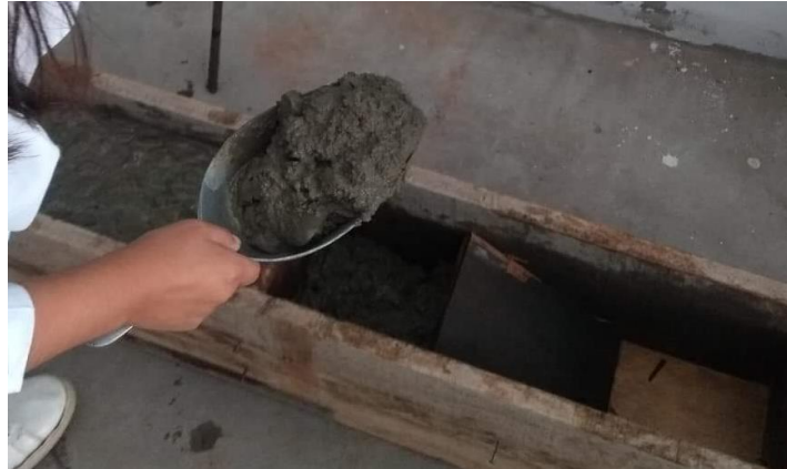
Figura 35. Vaciado de mezcla en el encofrado de madera con repartición diagonal.
