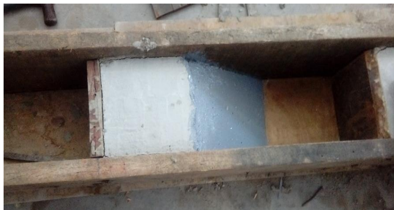
Figura 36. Viga de concreto endurecido luego de la aplicación Sikadur 32 Gel.
