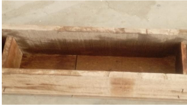
Figura 22. Encofrados de madera para vigas.
