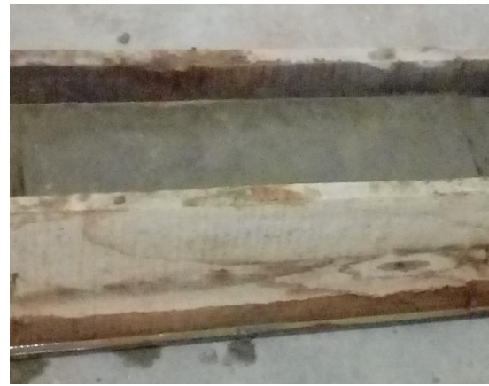
Figura 28. Llenado de las probetas y vigas de concreto.
