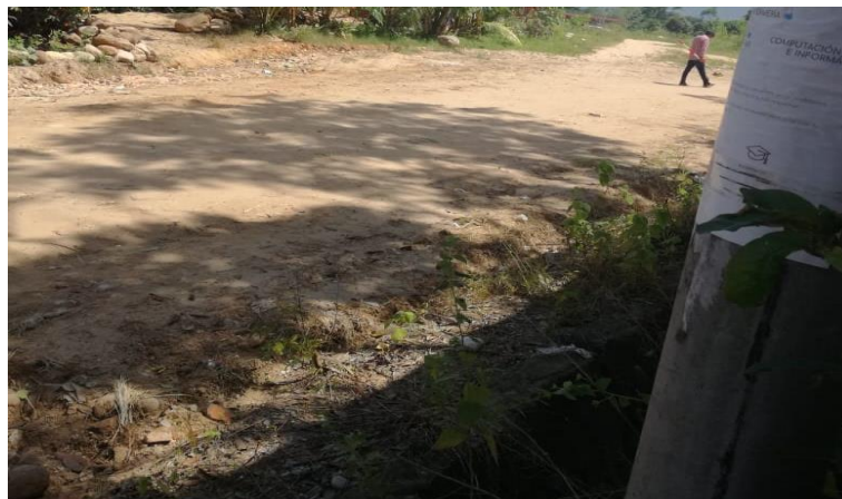
EN LA IMAGEN SE OBSERVA EL ESTADO DE LAS CALLES ACTUALMENTE EN PÉSIMO ESTADO
