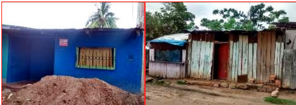
EN LA IMAGEN SE MUESTRA LAS VIVIENDAS DE ADOBE, A LA IZQUIERDA, Y DE MADERA, A LA DERECHA, CON COBERTURA DE CALAMINA.
