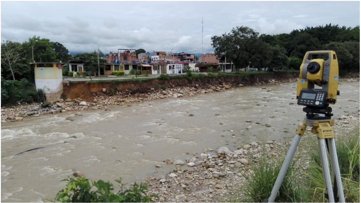
FOTO 03: Panorámica del levantamiento topográfico donde se muestra el estado del cauce del río
