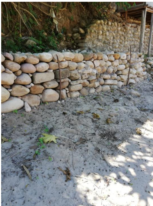
FOTO 06: Defensa ribereña provisional realizada por los pobladores del sector.
