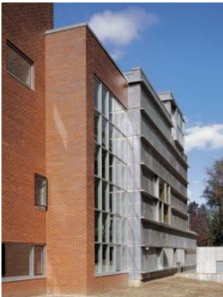
Figura 22. Vista de fachada
