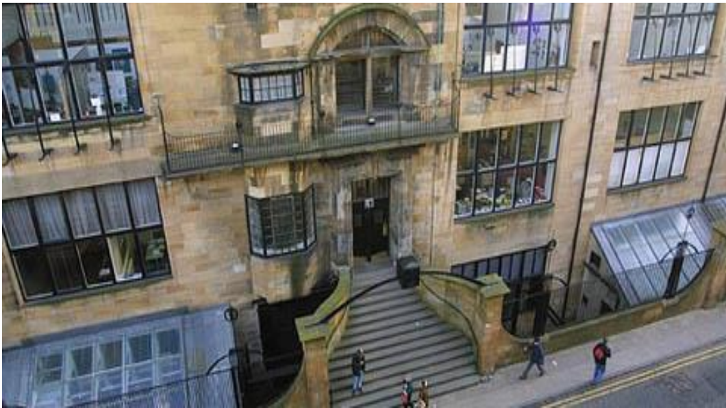
Figura 11. Vista de Elevación de la Escuela de Arte de Gasgow
