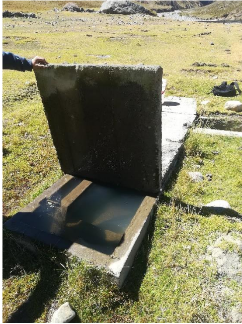
Imagen N° 04: desarenador
