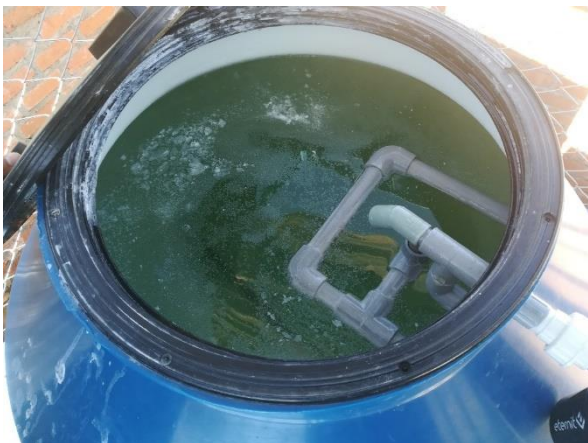
Imagen N° 09: Tanque de cloración
