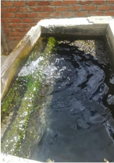
Imagen N° 08: mal estado de la cámara de filtro
