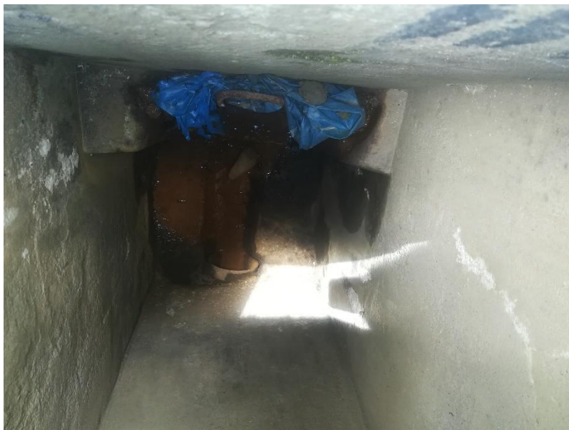
Imagen N° 05: desarenador fuera de uso
