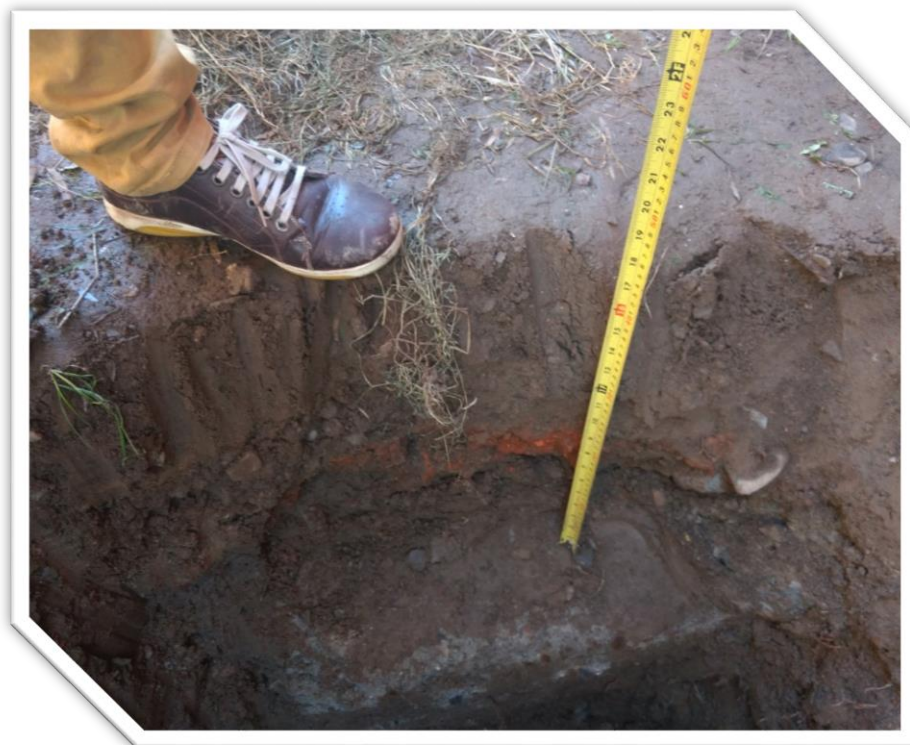
Figura 05 y 06: Auscultación de la zapata
