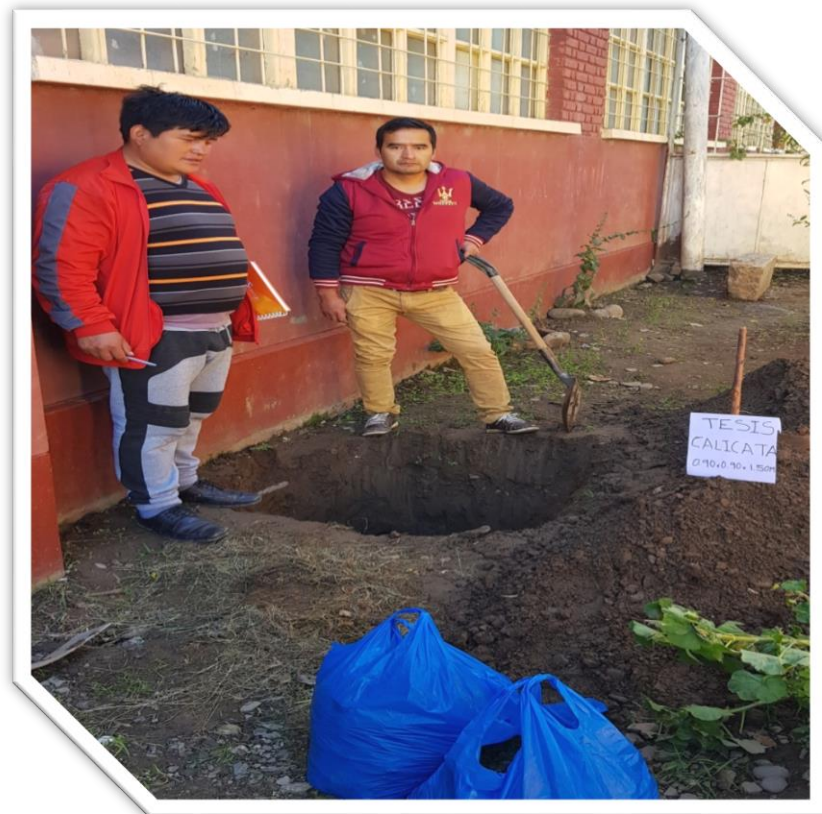
Figura 04: excavación final de calicata con dimensiones de 0.90x0.90x1.50m.
