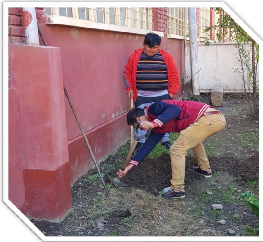
Figura 03: inicio de excavación de calicata
