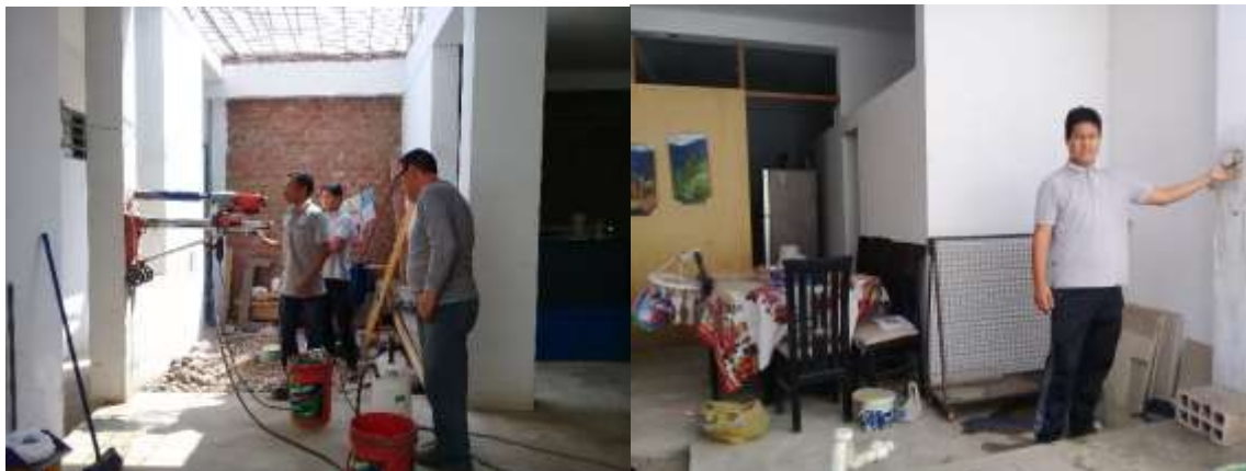
Gráfico 4. Extracción de núcleos de concreto
