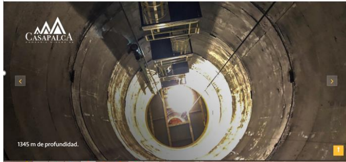
Figura 23: CASAPALCA Cia. Minera SA., Proyecto en la unidad (pique circular)
