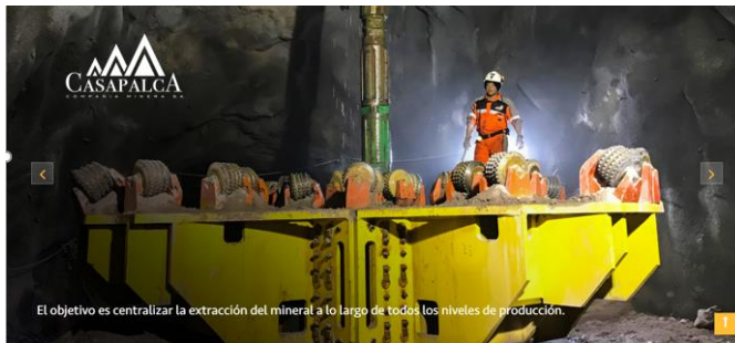
Figura 25: CASAPALCA Cia. Minera SA., Proyecto en la unidad
