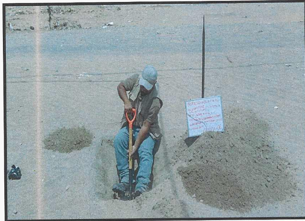
Excavación de calicata C-06
