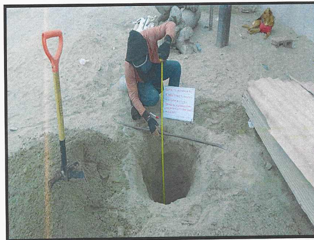
Excavación de calicata C-01
