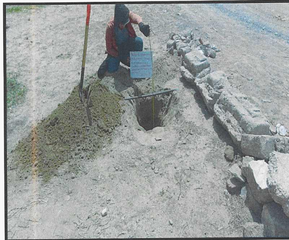
Excavación de calicata C-05
