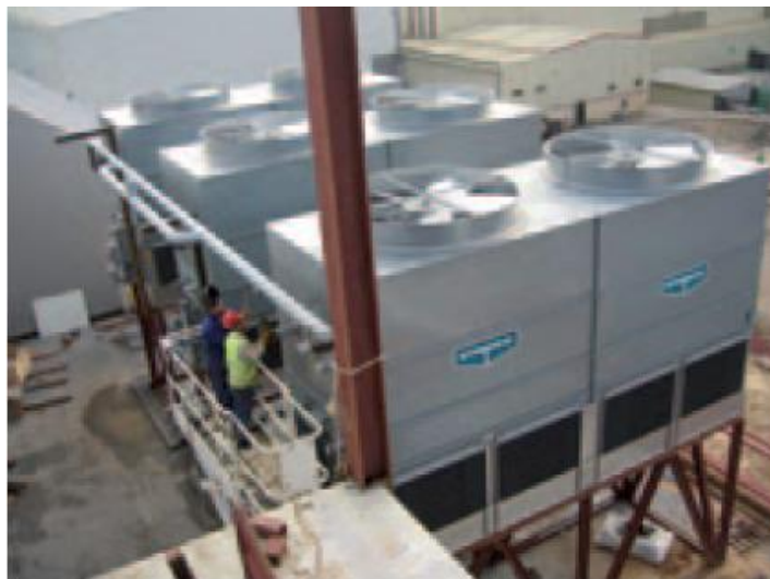
Figura 6: Condensador evaporativo.
