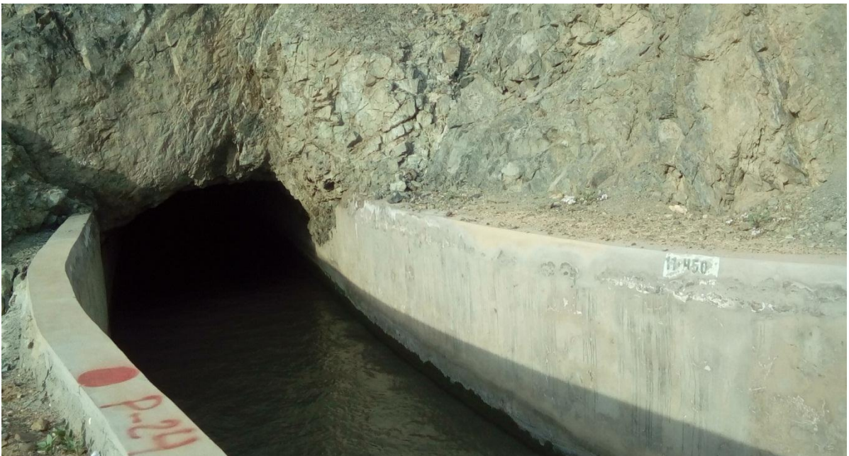
Fotografía. N° 06. Salida del túnel N°05, e ingreso a la zona de estudio del canal “IRCHIM”, ubicada en la progresiva 11+300.
