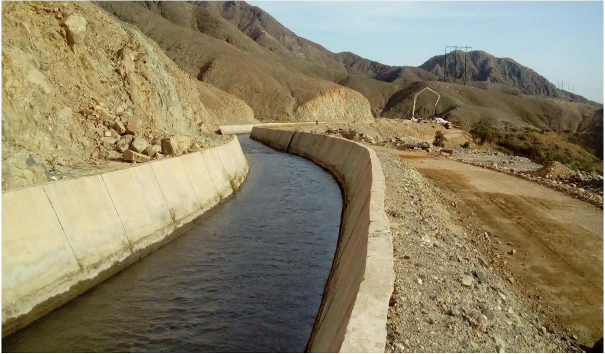
Fotografía. N° 03. Actualmente el canal transporta un caudal de 12 m 3 /s aprox., siendo su capacidad de diseño max. de 35 m 3 /s.
