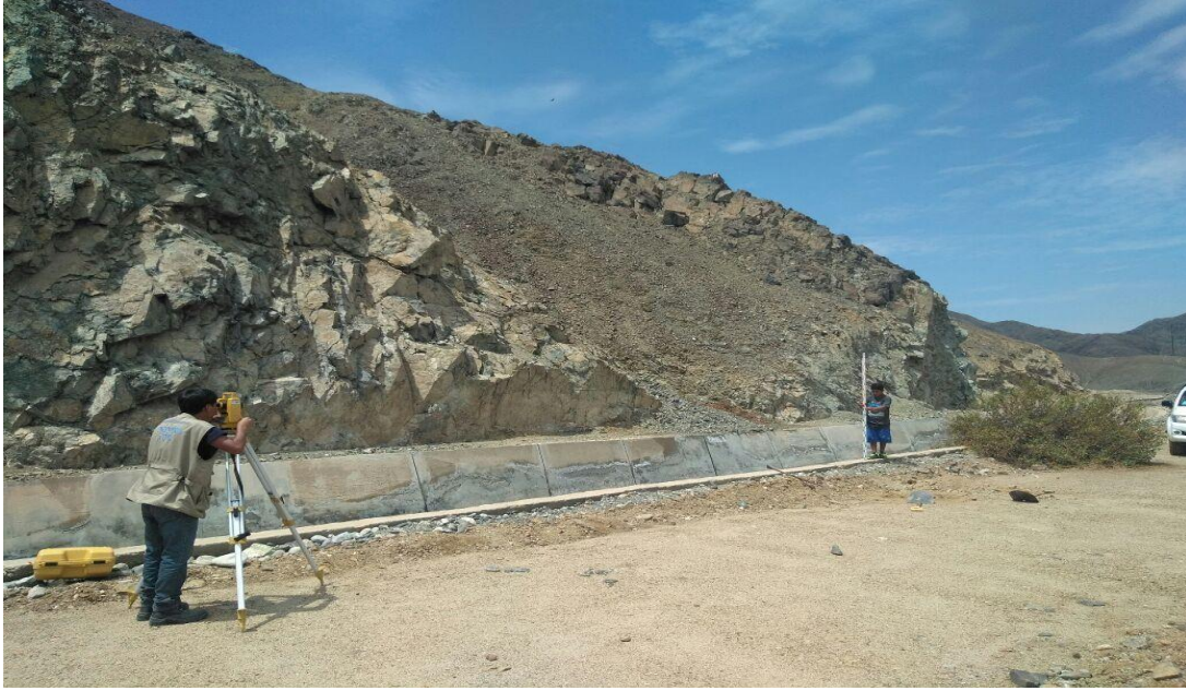
Fotografía. N° 13. Se realizó el cambio de estación en la progresiva 11+650 considerando la vista atrás y vista adelante.
