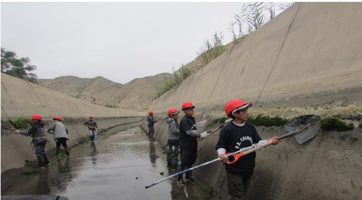
Fotografía. N° 18. Se observa en la imagen al personal realizando trabajos de mantenimiento.
