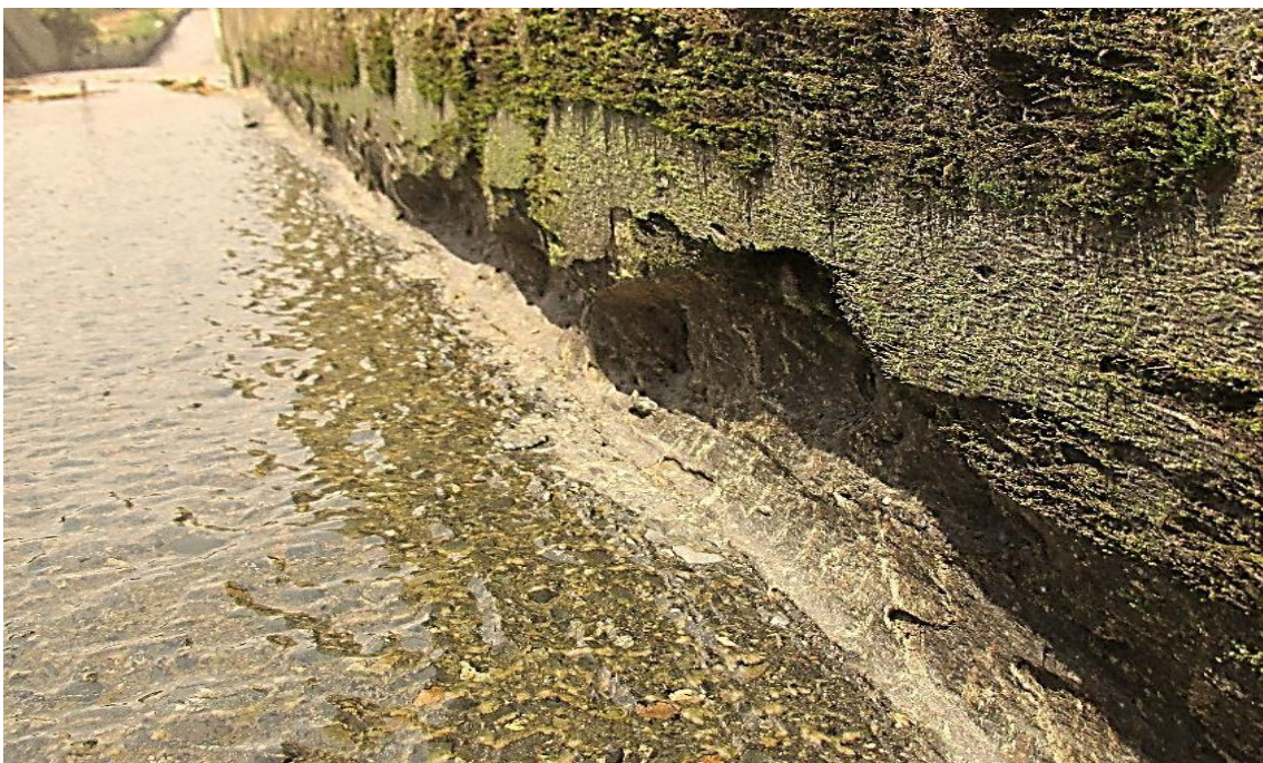
Fotografía. N° 19. Se observa en la imagen el fondo y el margen derecho del canal “IRCHIM”, erosionado producto del flujo que transita en la infraestructura.
