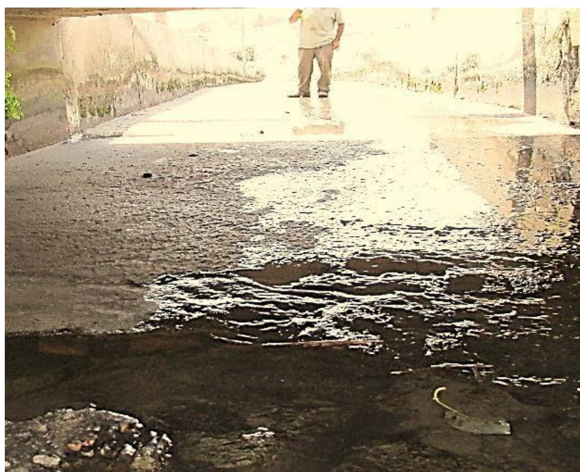
Fotografía. N° 19. Se observa en la imagen el fondo y el margen derecho del canal “IRCHIM”, erosionado producto del flujo que transita en la infraestructura.
