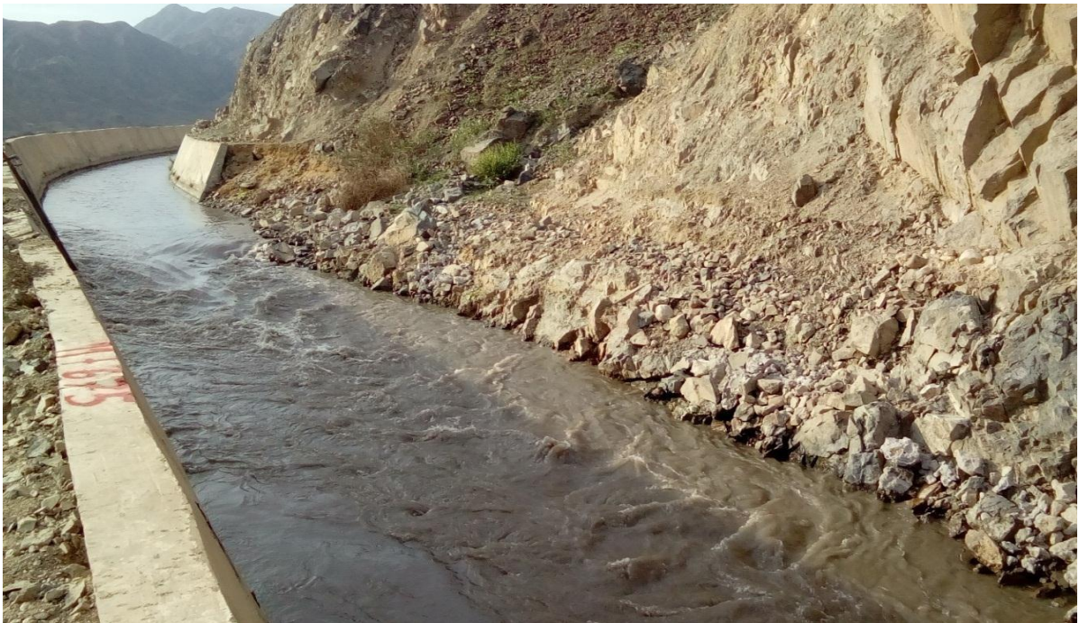
Fotografía. N° 04. En la imagen se aprecia el margen izquierdo del canal IRCHIM ubicado en la progresiva 11+765.
