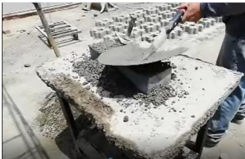
Compactado del ladrillo
