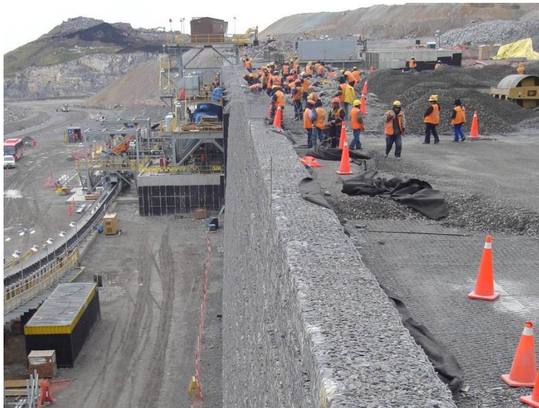
Figura 3-Construcción de un muro de suelo reforzado.
