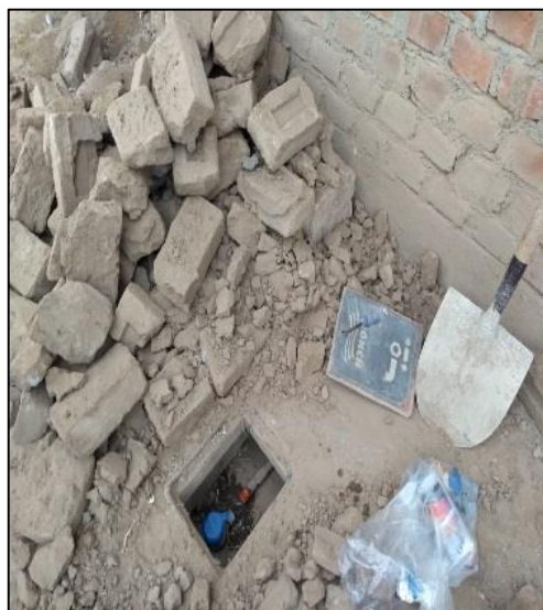
Figura 37: Apoyo de la supervisión en campo conexión con desmonte sobre caja
