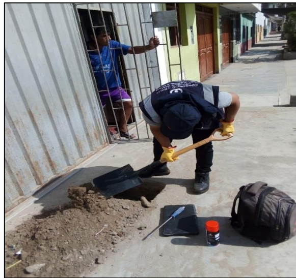
Figura 36: Apoyo de la supervisión en campo desenterrando una conexión
