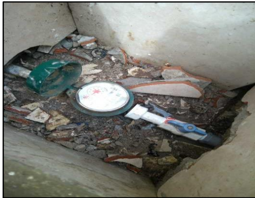
Figura 16: Trabajo de reconexión.
