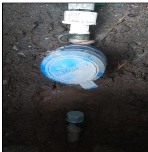
Figura 11: Corte simple retiro de válvula.
