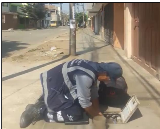
Figura9: Ejecución de Corte.
