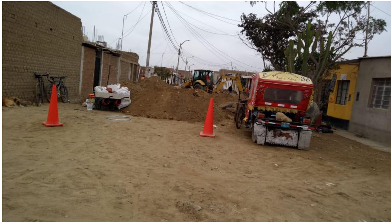
Figura 42: Trabajos de trabajos de instalación de gas domiciliario
