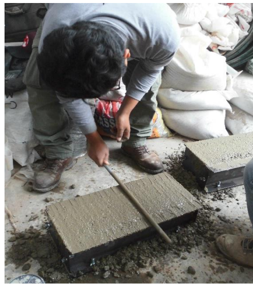
Enrasado de la viga
