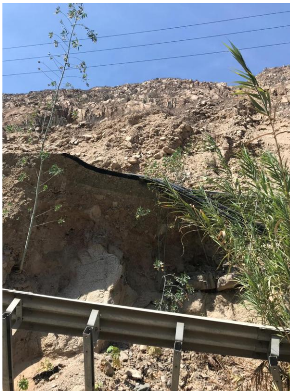
FIGURA 3.4 VISTA SUPERIOR DE TRAMO DE VÍA EN SANTA ROSA DE QUIVES
