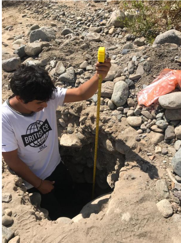
FIGURA 3.3 EXCAVACIÓN PARA CALICATA EN TRAMO DE ESTUDIO
