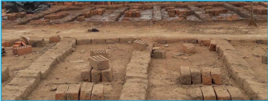
Figura 16. Parte superior del horno
