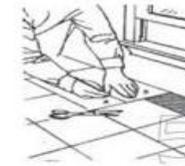
Para cortar con precisión de loseta de la hilera final que completa el piso: Sobre poner la loseta A sobre la última que se pego al piso. Encimar una segunda loseta "B" sobre la "A" haciendo que el borde opuesto asiente perfectamente en la pared. Utilizando esta loseta como regla, trazar una línea de lápiz sobre la loseta "A" para marcar la línea de corte. Efectuar el corte, cuidando de hacerlo perpendicular a la superficie de la loseta.
