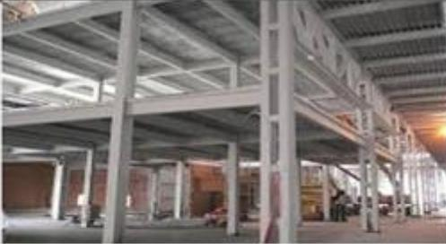
La placa colaborante, conocida también como steel deck es un sistema constructivo para losas de entrepiso que se compone una placa de acero nervada inferior apoyada sobre un envigado y que permite recibir el hormigón vertido que completa la losa. La placa nervada actúa como encofrado perdido y queda incorporada al conjunto, actuando como parte de la enfierradura de refuerzo a tracción en la cara inferior de la losa.
