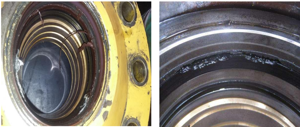
Figura 11. Sellos deteriorados internamente de los cilindros hidráulicos de una excavadora PC-4000.
