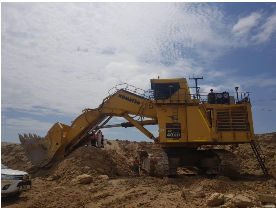
Figura 6. Excavadora PC-4000 Front Shovel.
