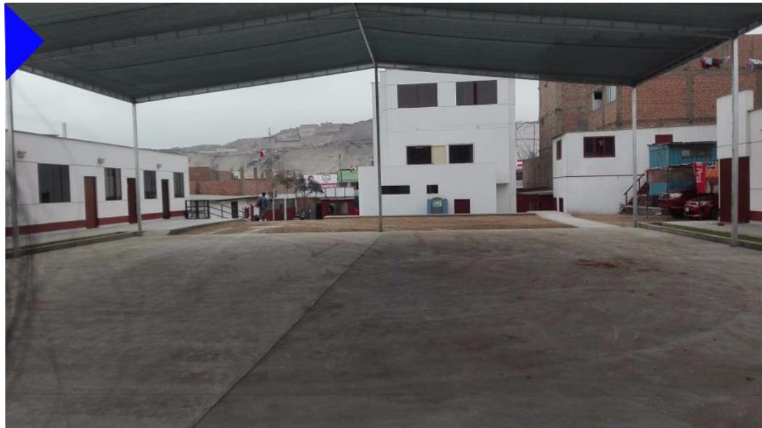
Figura 133: Fotografía interna, vista del patio interno de este a oeste.
