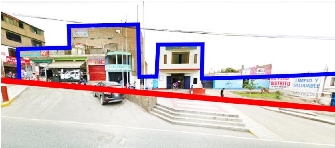
Figura 97: Perfil urbano de la Av. Ayacucho
