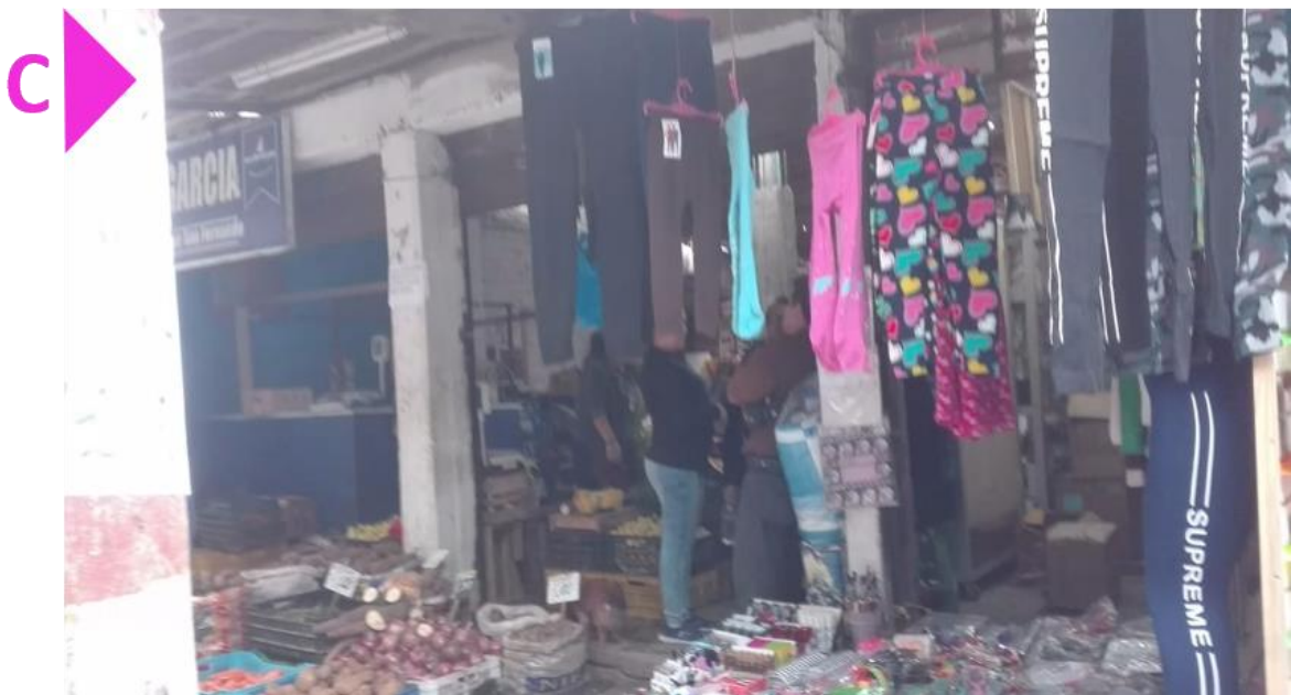
Figura 125: Fotografía del pasaje peatonal, infraestructura deteriorada.
