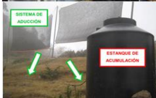
Figura 91: El atrapanieblas como sistema de recolección de agua.
