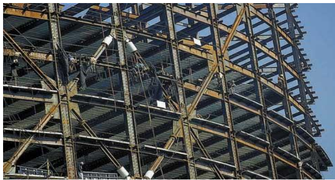
Figura 4. Instalación de los disipadores viscosos
