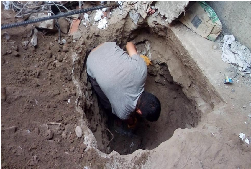
FOTO N° 3: Excavación de calicata
