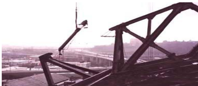
Figura 6. Instalación de los disipadores viscosos
