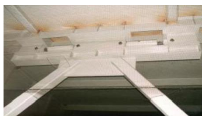
Figura 18. Disposición Chevron y su refuerzo adicional
