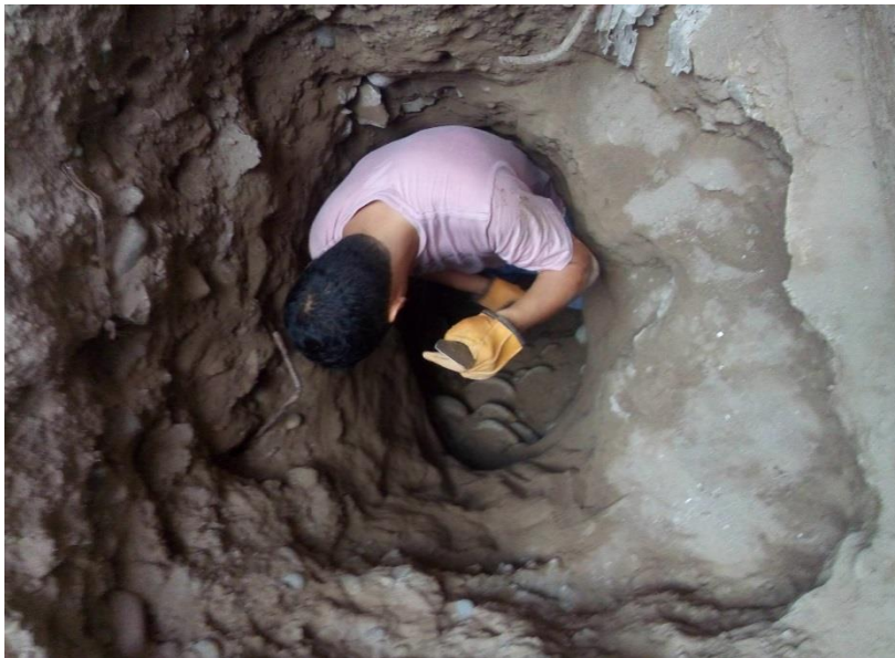
FOTO N° 2: Excavación de calicata
