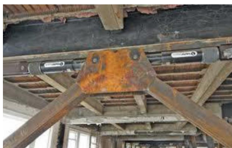
Figura 17. Disposición Chevron
