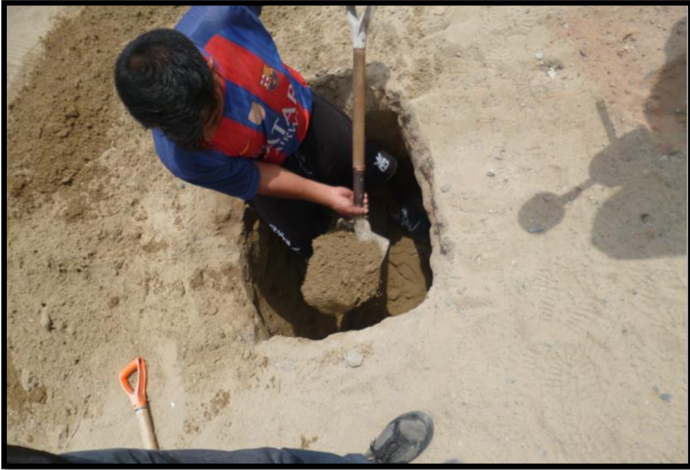
IMAGEN N° 3: Excavación de calicatas en el área de estudio. Fuente: Elaboración propia.
