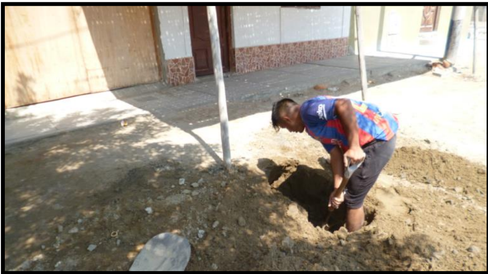
IMAGEN N° 4: Excavación de calicatas en el área de estudio. Fuente: Elaboración propia.
