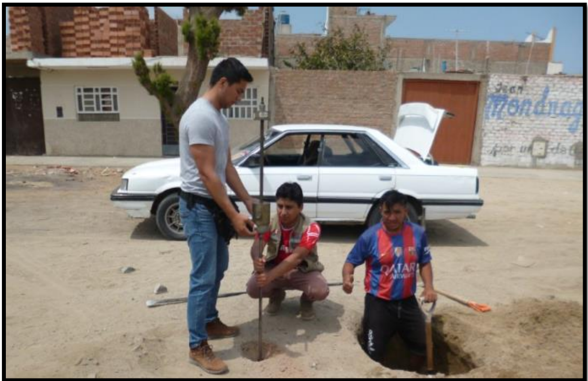
IMAGEN N° 8: Se realizó en ensayo DPL a 1m de distancia de cada calicata. Fuente: Elaboración propia.
