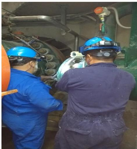
Figura N°4: Retiro de pernos en tapa de intercambiador lado B
