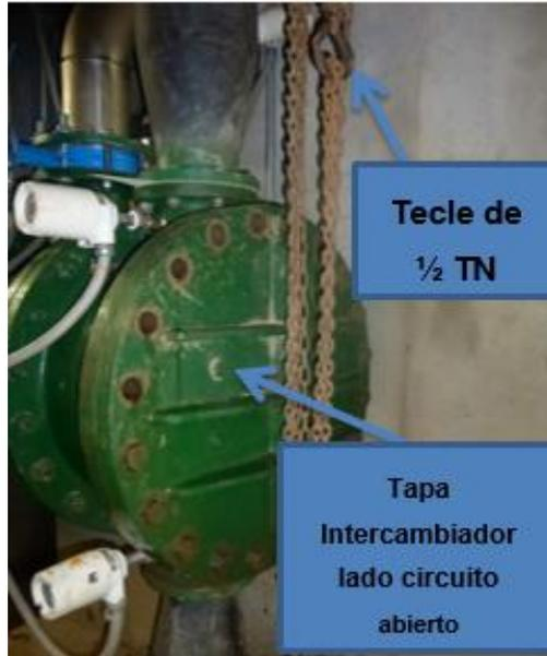
Figura N°2: Tapa de intercambiador lado A
