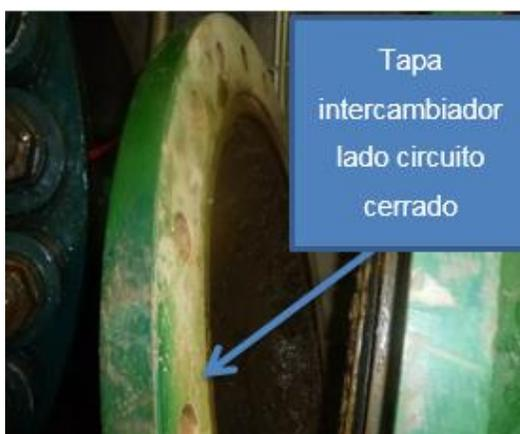
Figura N°5: Desmontaje de tapa de intercambiador lado B
