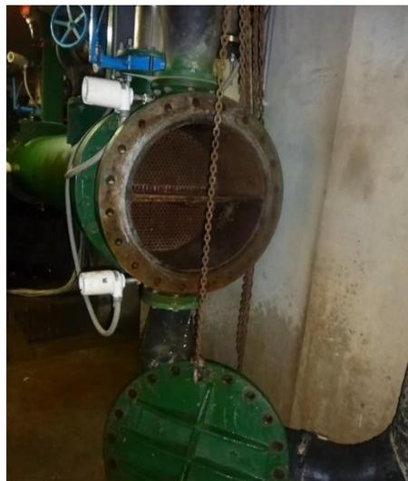
Figura N°3: Desmontaje de tapa de intercambiador lado A
