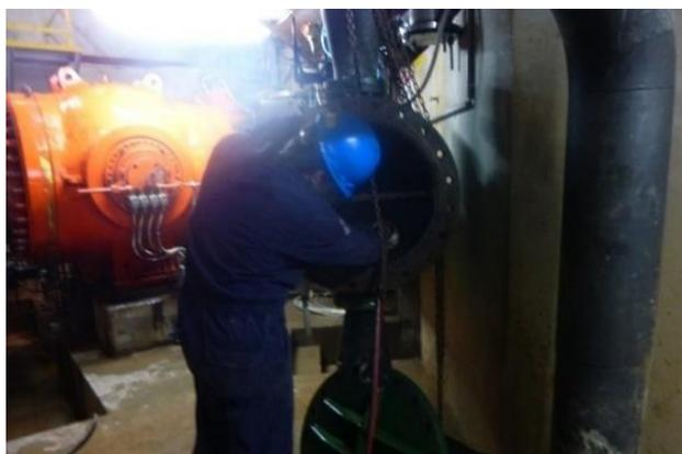
Figura N°7: Limpieza de intercambiador con agua y aire
