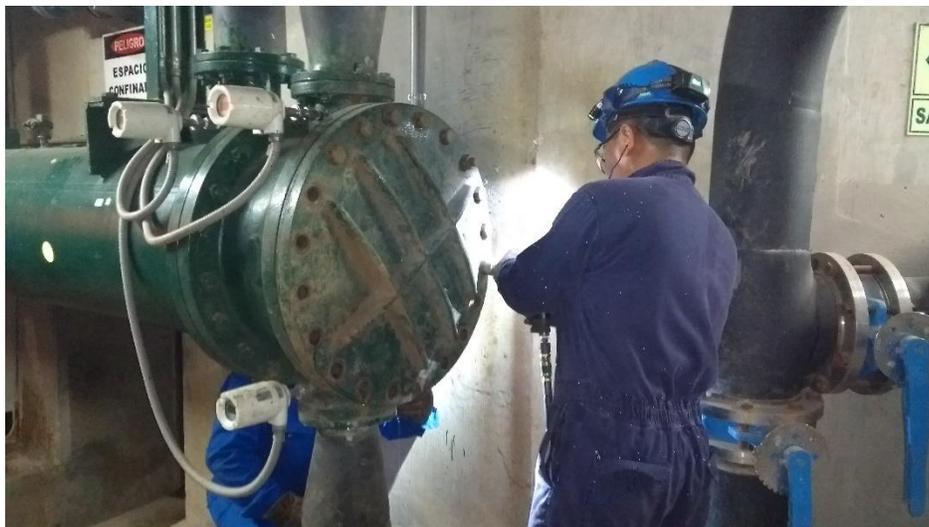
Figura N°1: Retiro de pernos en tapa de intercambiador lado A
