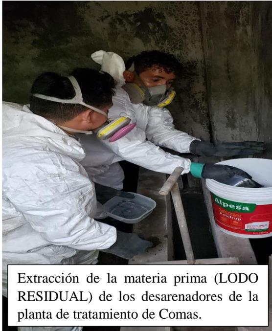
Extracción de la materia prima (LODO RESIDUAL) de los desarenadores de la planta de tratamiento de Comas.
