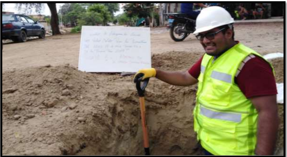
FIGURA N°51: Se observa la elaboración de la calicata N°03 en donde se extrajo una solo muestra de la zona para calcular las propiedades físicas y mecánicas del suelo.
