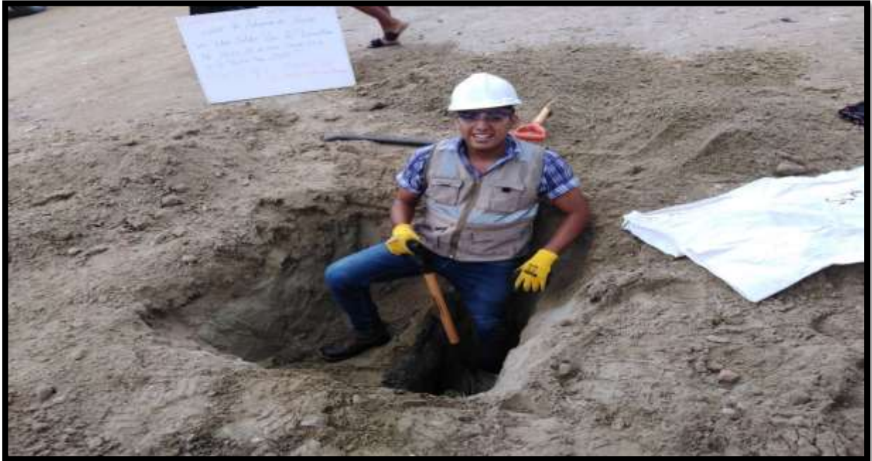
FIGURA N°52: Se observa la elaboración de la calicata N° 04 donde se extrajo una sola muestra en la zona de estudio para calcular las propiedades físicas y mecánicas del suelo.
