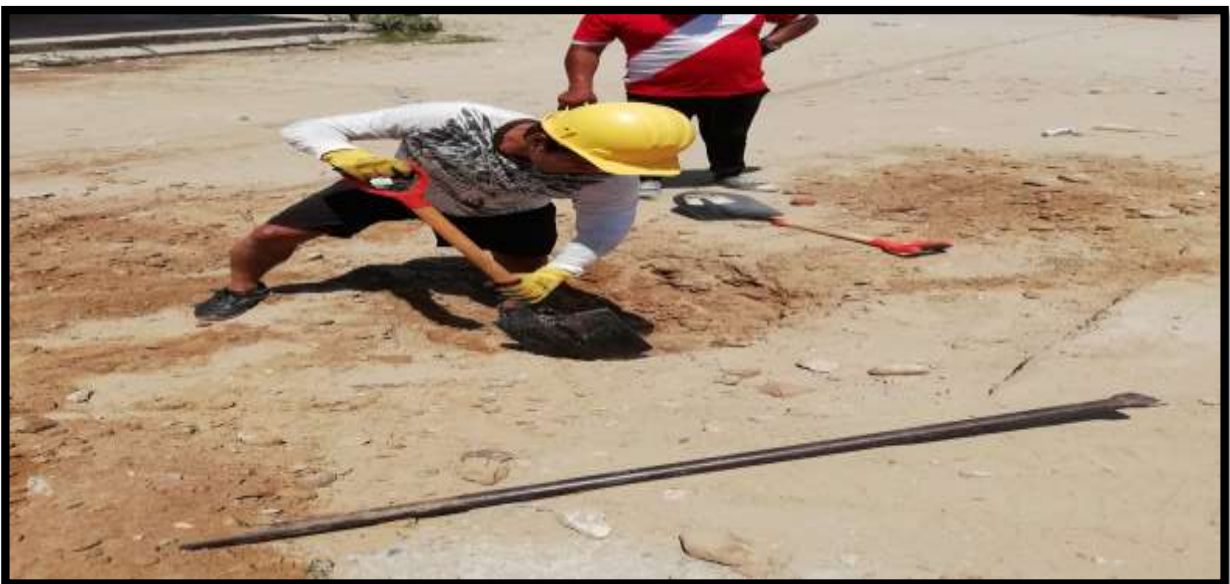
Figura 49: Excavación de calicatas: Se observa la excavación de calicata N° 01 en situ las cuales se extrajo la muestra de cada una para hacerles los diferentes ensayos de laboratorio.
