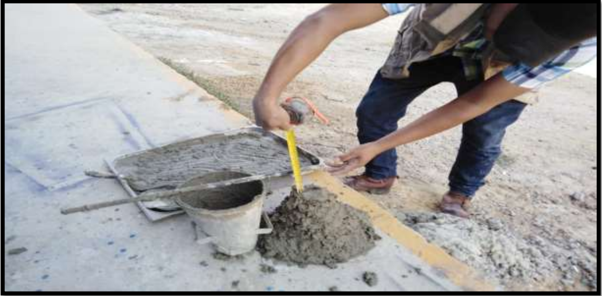
FIGURA N°80: Se observa la elaboración del ensayo SLUMP de 4” para determinar la trabajabilidad del concreto que se usó para el diseño de mezcla.
