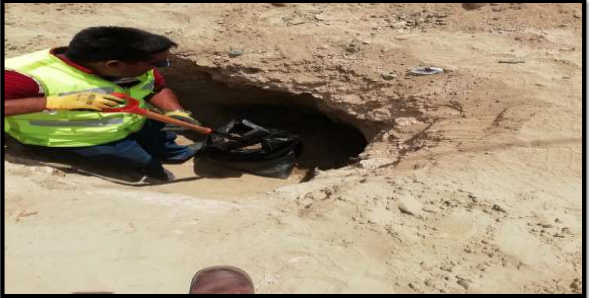
Figura 50: Excavación de calicatas: Se observa la extracción de las muestras en cual se hizo los diferentes ensayos para determinar las propiedades físicas y mecánicas del suelo.
