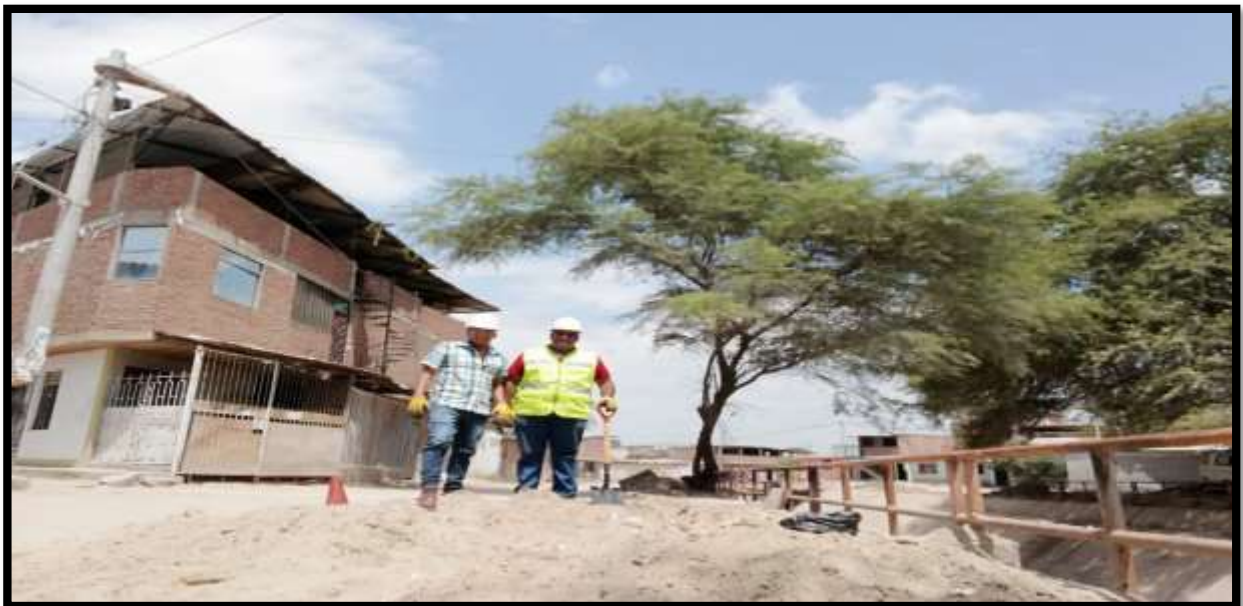
FIGURA 53: Se observa la extracción de la muestra de la calicata N°04 en situ de la zona de estudio, siendo la ultima de las 04 calicatas para los diferentes ensayos que se hicieron en laboratorio.
