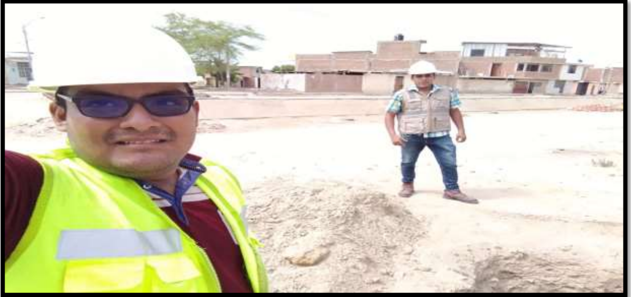
FIGURA N°76: Se observa la realización del estudio de tráfico para calcular el ESAL para determinar los espesores del paquete estructural del pavimento.
