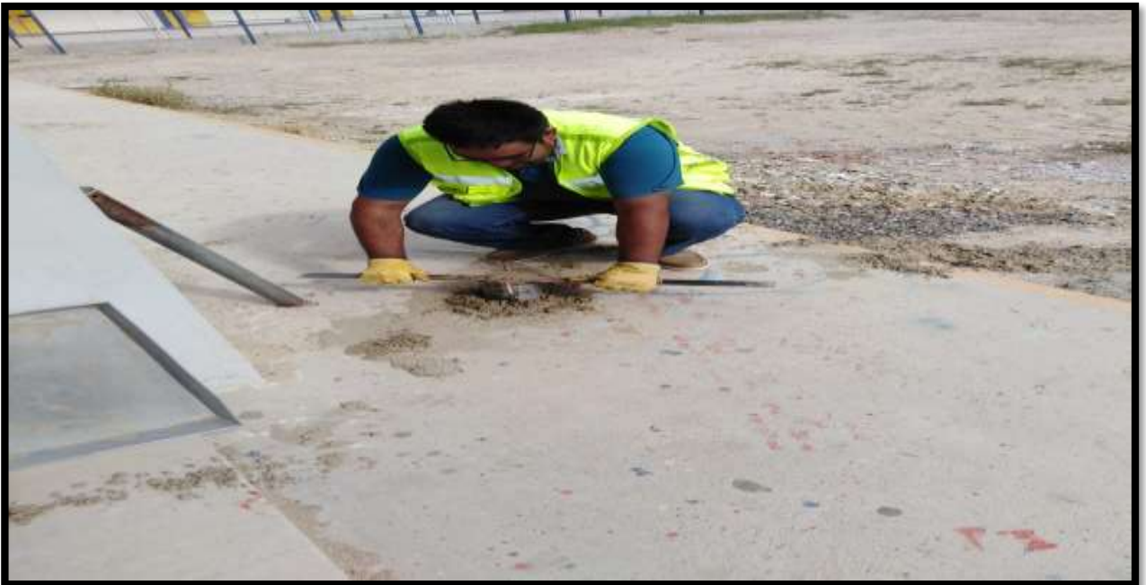
FIGURA N°63: Se observa la elaboración del ensayo del CBR de las 4 muestras extraídas de las zonas para calcular las propiedades físicas y mecánicas del suelo.
