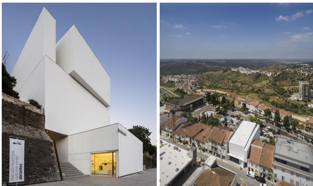
Ilustración 220, Vista exterior. Fuente: Archdaily (2018).
