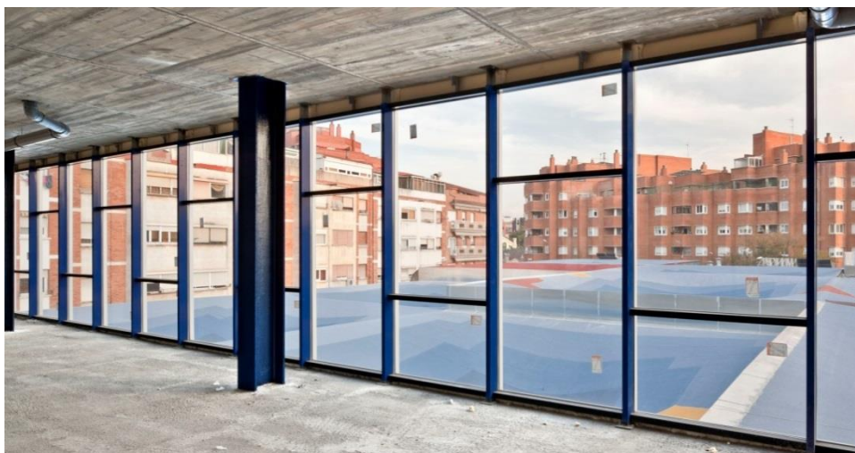
Ilustración 214. Vista desde el interior hacia el exterior del mercado. Fuente: Archdaily (2018).
