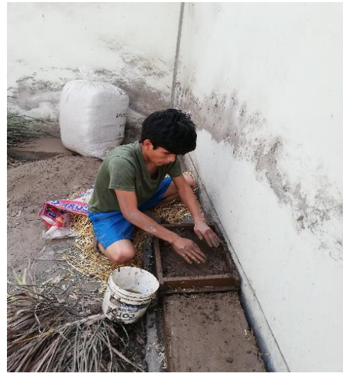
Figura 21: Colocación de la mezcla de barro con emulsión asfáltica
