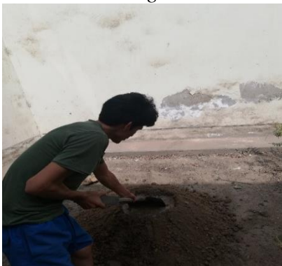
Figura 16: Mezcla del material de suelo con agua
