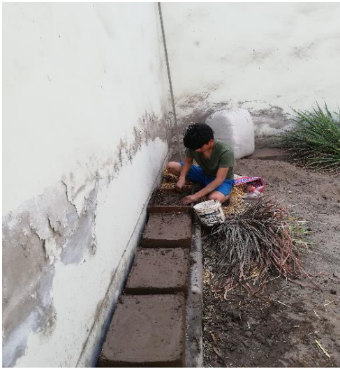
Figura 33: Colocación del barro en la adobera
