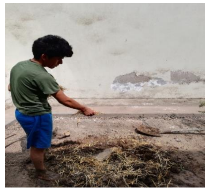
Figura 15: Adición de la paja y pisado de barro
