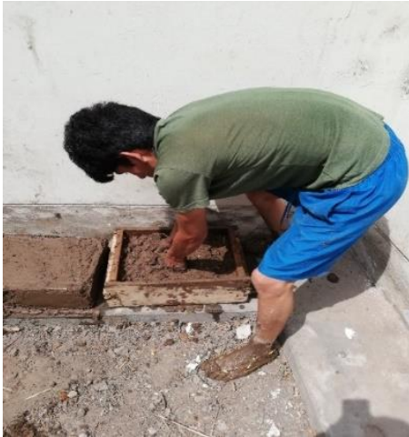
Figura 18: Colocación de la mezcla de barro en la adobera
