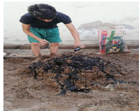
Figura 19: Adición de la emulsión asfáltica en la masa
