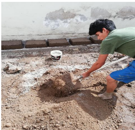
Figura 27: Preparación del material
