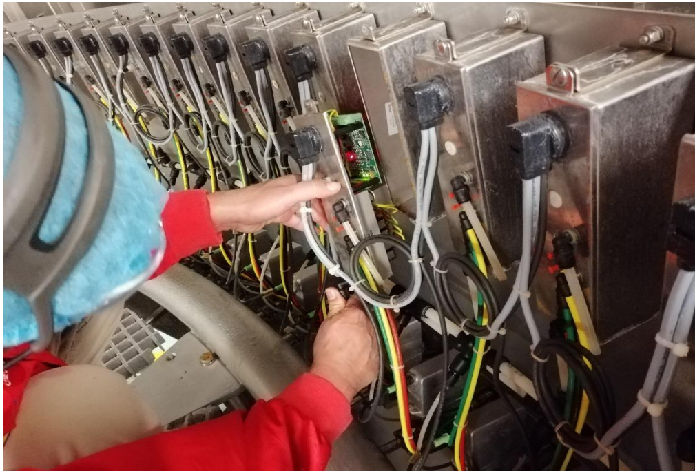
FIGURA 20. DESMONTAJE DE ELECTROVÁLVULA PARA SIMULAR LA INDEPENDIZACIÓN.
