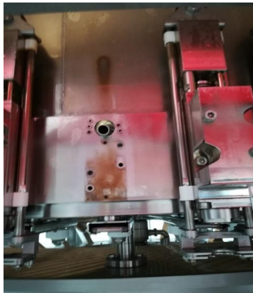
FIGURA 19. DESMONTAJE DE VÁLVULAS
