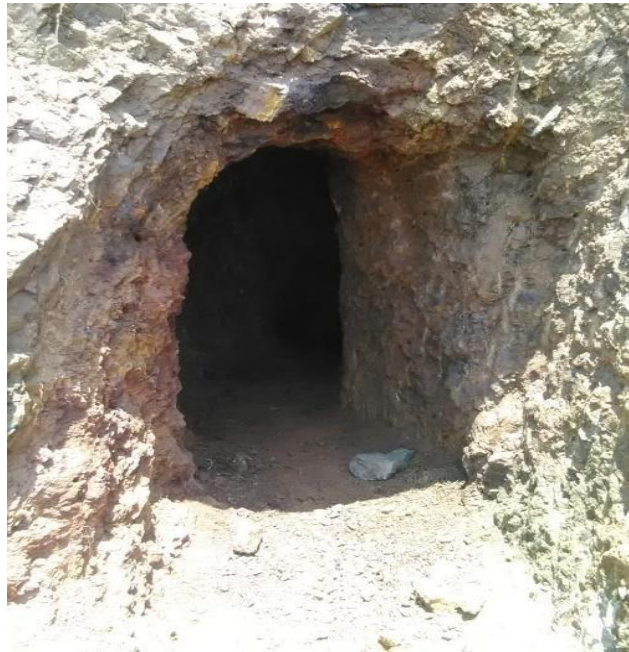
Fotografía 6: Frente volado con emulsiones (Galería 322)
