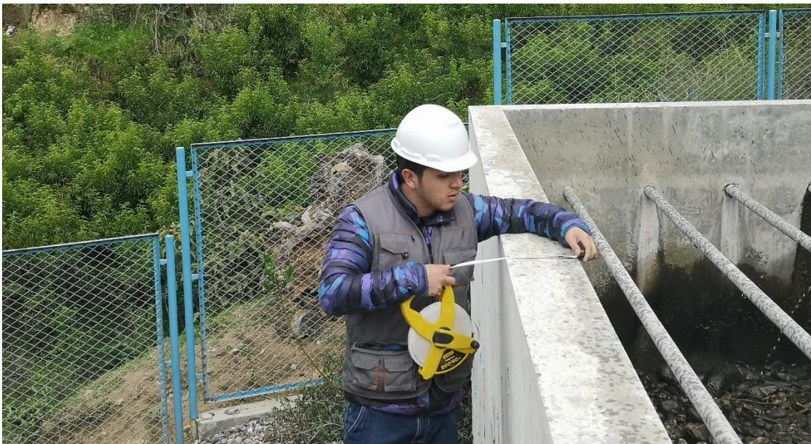
Figura 21 Evaluación de patologías en el Filtro Biológico
