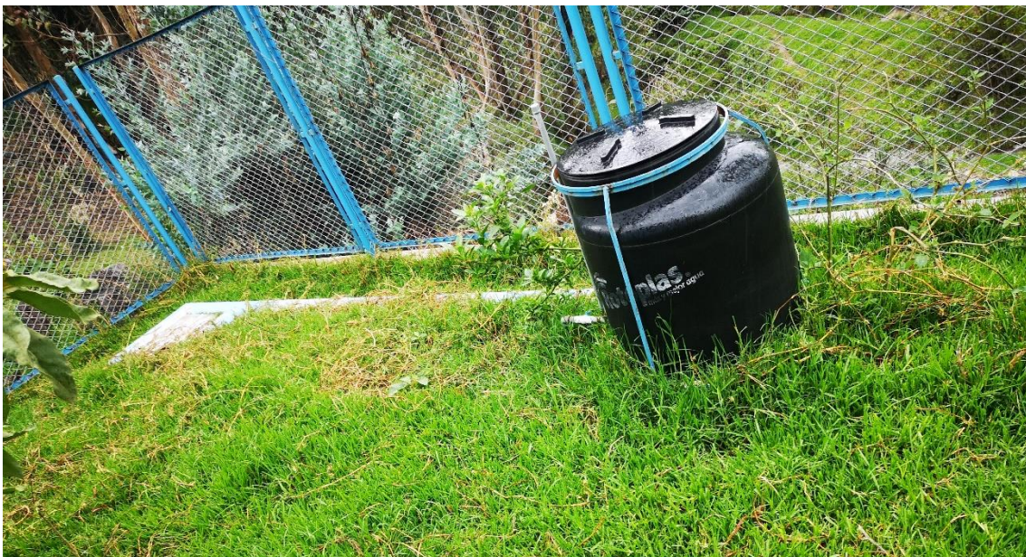
Figura 30 Evaluación de patologías en el Contacto de Cloro
