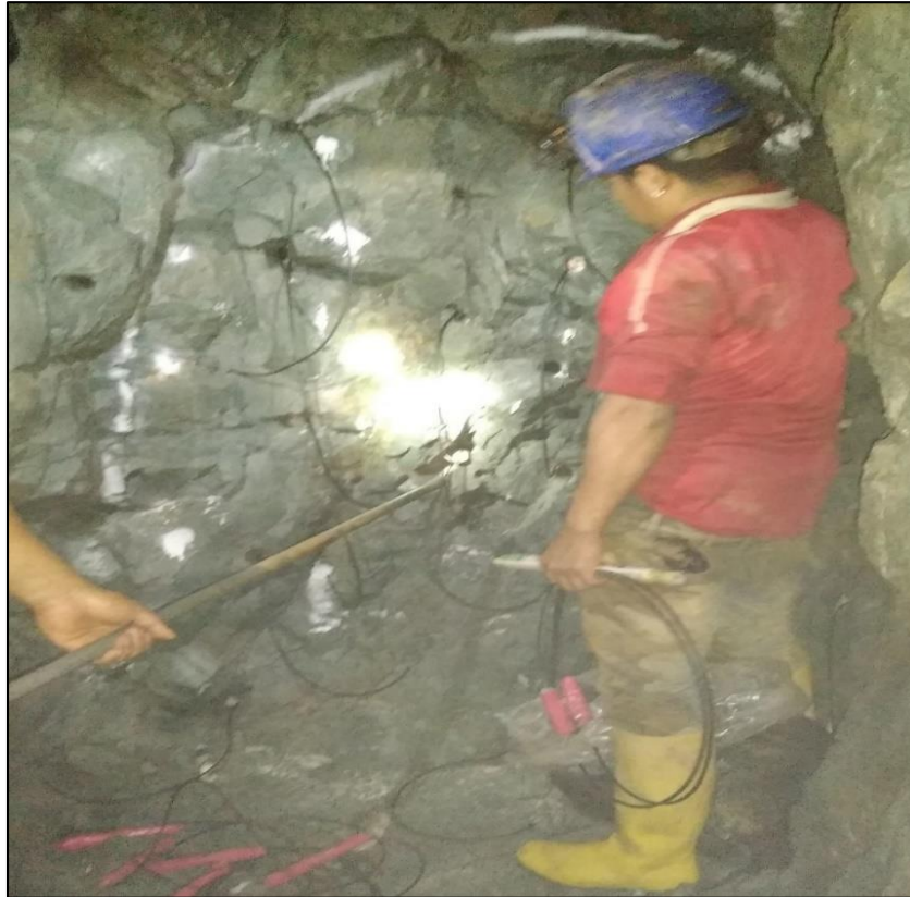
Figura 27. Carguo en Malla Optimizada de la perforación.
