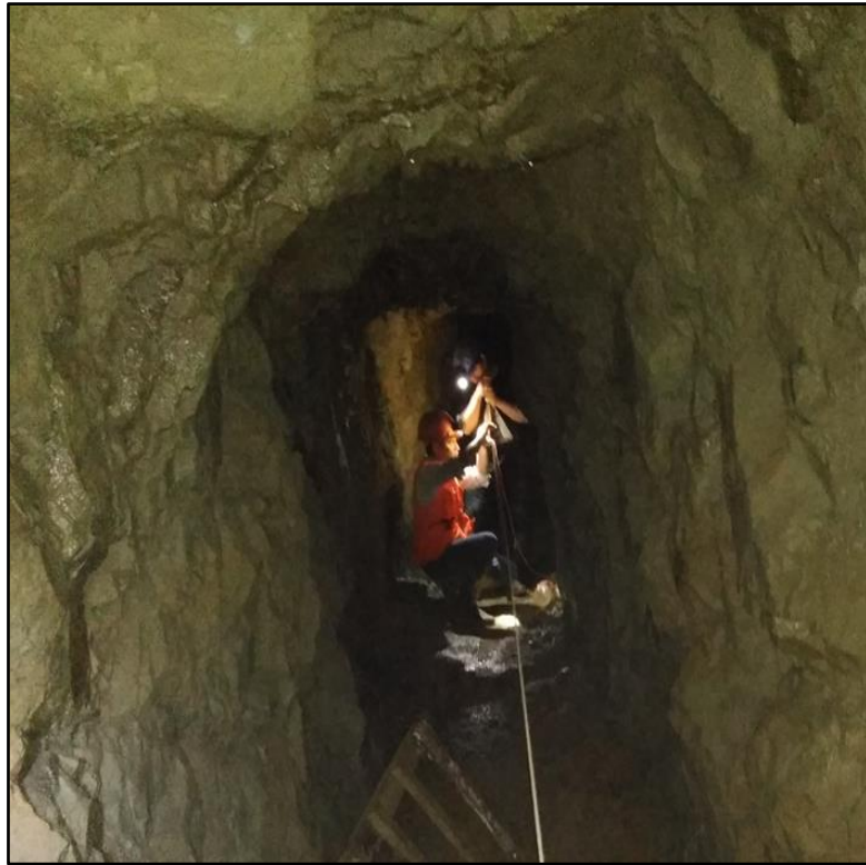
Figura 5. Mediciones del levantamiento topografico subterraneo con metro y brujula
