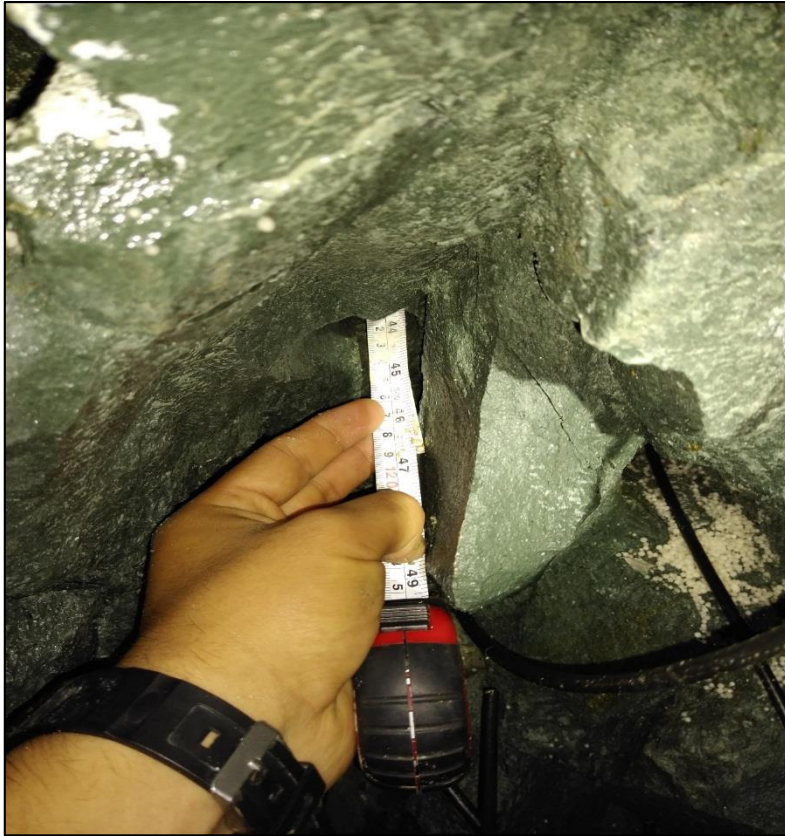
Figura 20. Longitud de perforacion (1.14 m)
