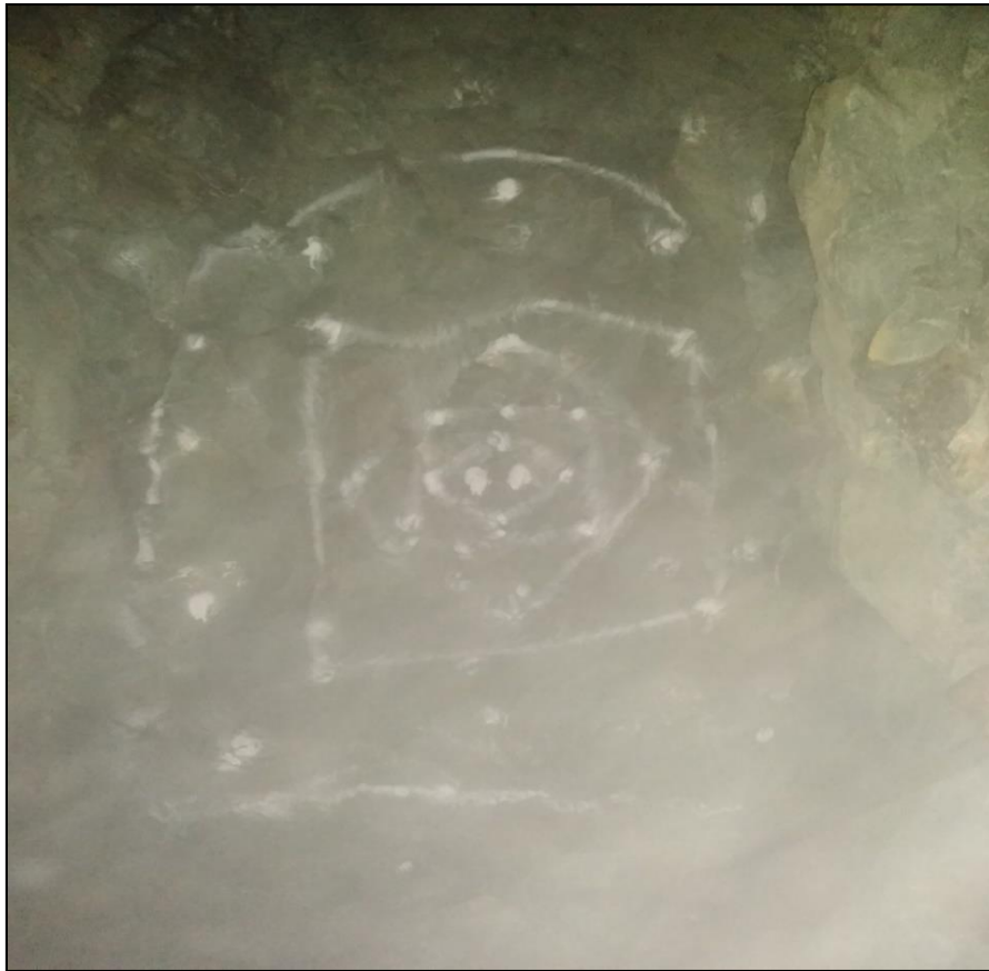
Figura 25. Malla Optimizada de perforación
