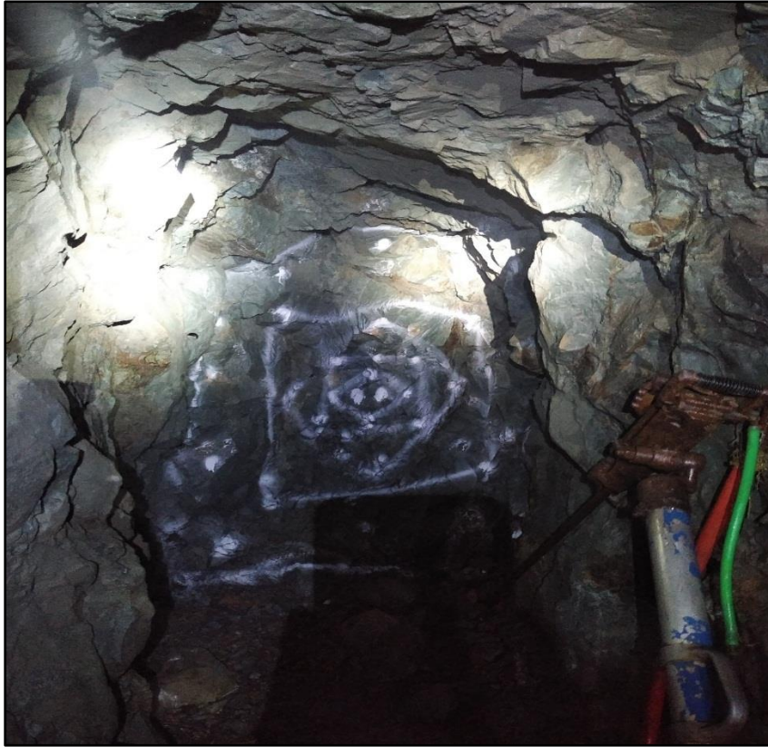
Figura 16. Malla de perforación (modelo matematico holmberg)
