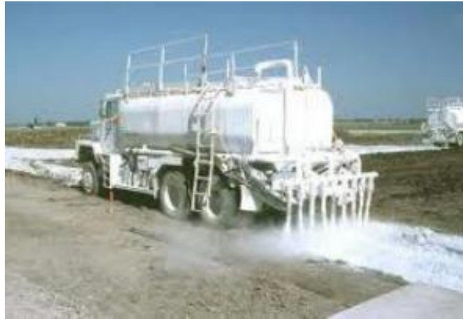
Figura 1. Uso de cal seca con aplicación mecánica
