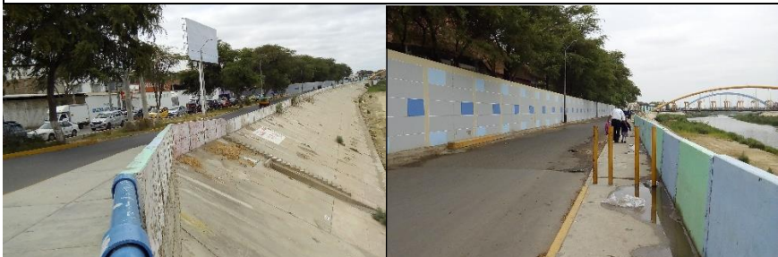
FOTO DEL TRAMO INTERVENIDO
