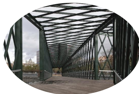
VISTA DE PASARELA EN Y
