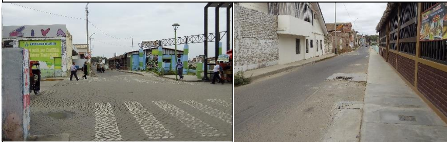
FOTO DEL TRAMO INTERVENIDO
