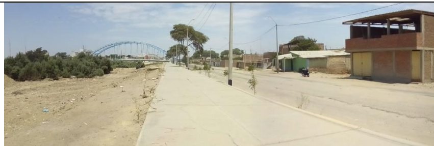
FOTO DEL TRAMO INTERVENIDO
