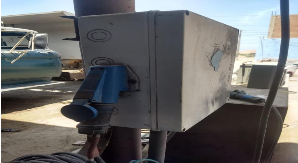
Figura 19: Actividad: Esmerilado/Soldeo/ Armar la estructura o esqueleto del producto Riesgo: Eléctrico
