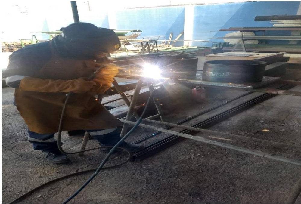
Figura 21: Actividad: Soldadura Riesgo: Físico Implementación de caballetes para reducir los riesgos ergonómicos
