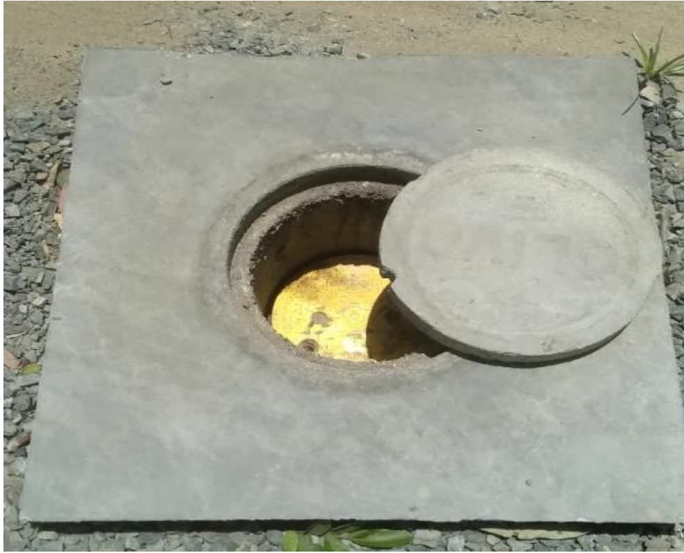
Figura 49: Implementación de pozo a tierra
