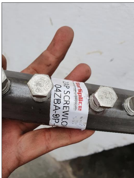
Figura 20: Conector mecánico de tornillo tipo 2 - Barsplice - 1/2”
