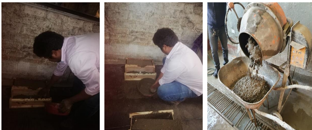
Figura 36: Vaciado de concreto
