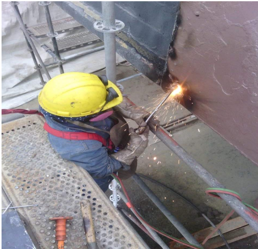
Anexo N° 29: Proceso de corte manual.
