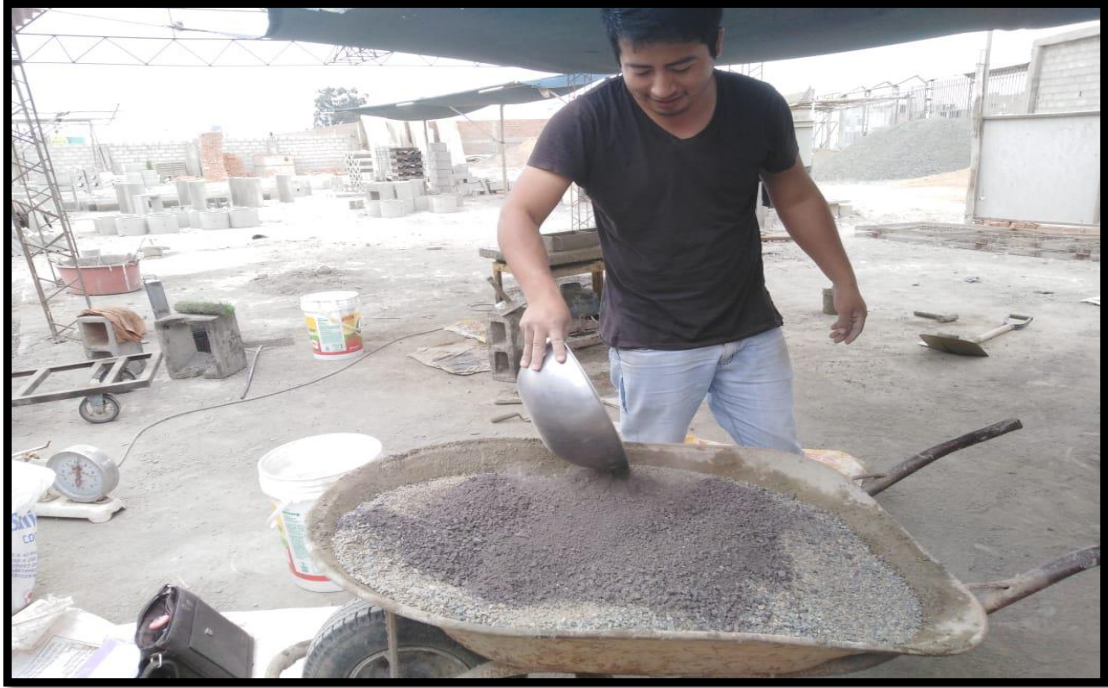
IMAGEN N° 3: PREPARACIÓN DE MEZCLA EN LADRILLERA “VARGAS” PARA ELABORACIÓN DE LARILLOS
