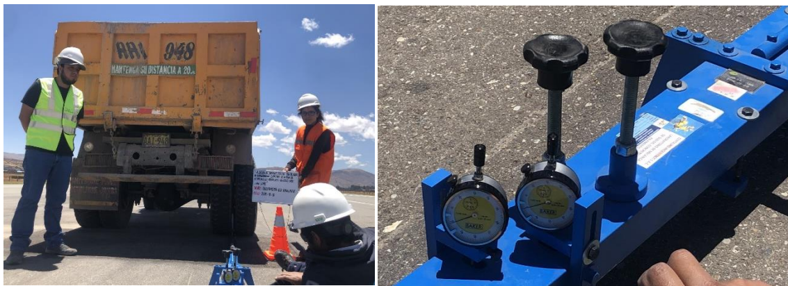
Figura N°17: Proceso de medición con la viga Benkelman
