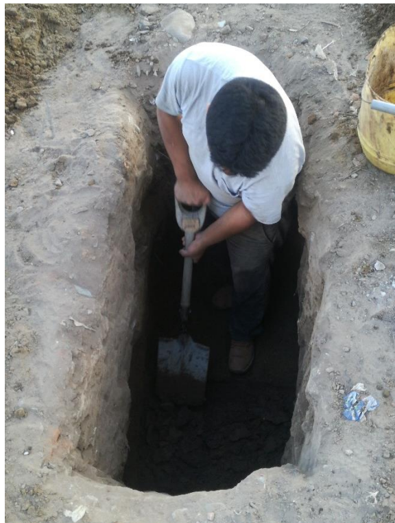
Excavación calicata C-2
