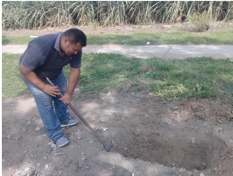
Inicio de excavación de calicata C-1
