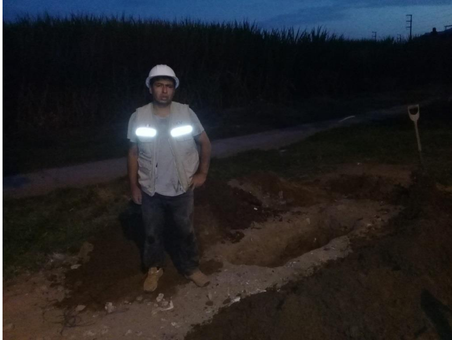
Calicata extraida C-1; inicio de llenado
