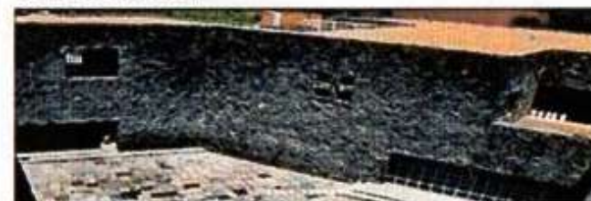
-El material predominante es la PIEDRA BRAZA y la PIEDRA VOLCÁNICA se emplea estos materiales para dar una imagen que caracteriza a la ciudad consignando una visión tradicional, el material es propio de la zona.
