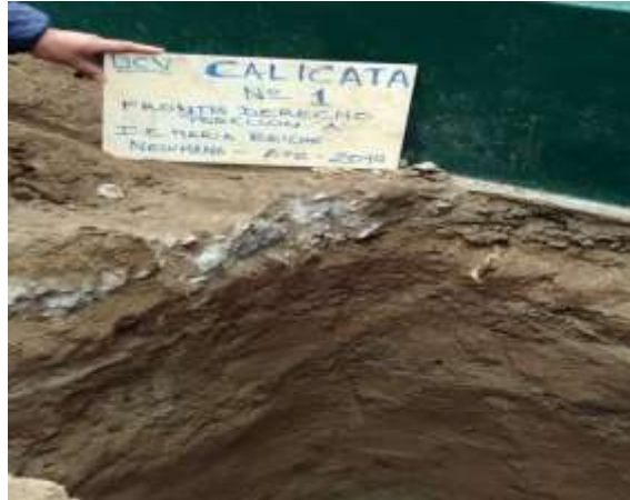
Figura 15.- Toma de muestra calicata N° 1de pabellón A de IE.
