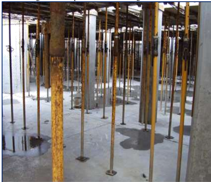
Figura 24 – Apuntalamiento de vigas
