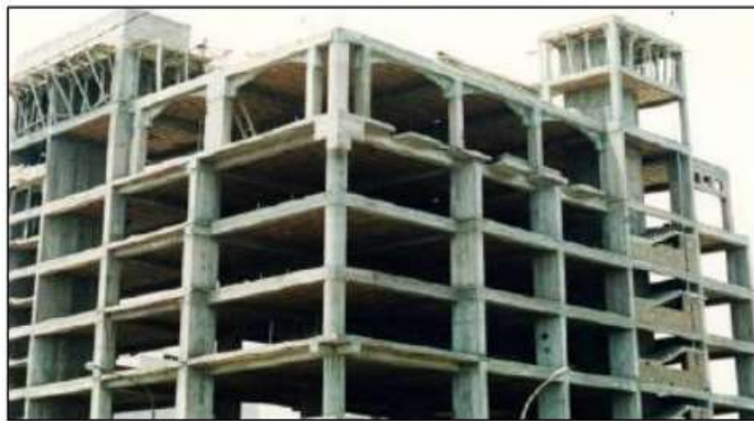
Figura 8.- Estructuración de concreto armado / aporcado
