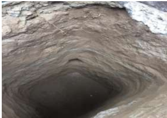
Figura 16.- Toma muestra calicata N° 2 de pabellón A de la IE.
