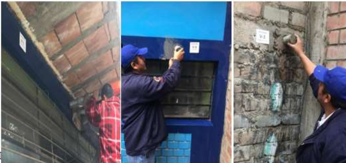
Toma de espécimen en vigas del pabellón A de la institución educativa.
