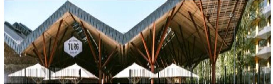
Todo el conjunto esta cubierto por un techo de madera modular los cuales se sostienen y amarran a una estructura metálica, asimismo esta se recubre con metal liviano de color negro..
