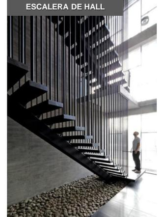
Usando barras de acero tensionados, sujetos a los peldaños del mismo material, generando un recorrido cerrado, hacia los diferentes niveles.
