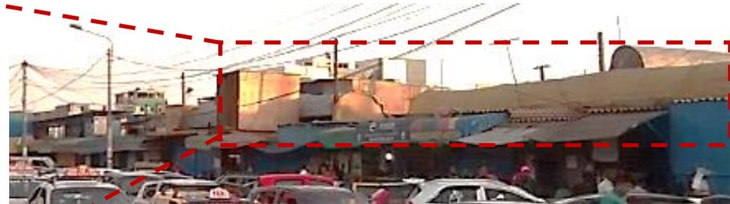
El mercado en su totalidad está hecho de estructura metálica, en su ingreso principal, a lo largo del eje se colocó un arco de acero recubierto con policarbonato amarillo.
