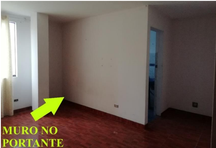
Ilustración 3 Muro no portante - Fuente propia
