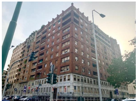
Ilustración 2 Construcción estructural - Fuente propia
