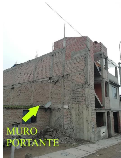
Ilustración 4 Muro portante - Fuente propia
