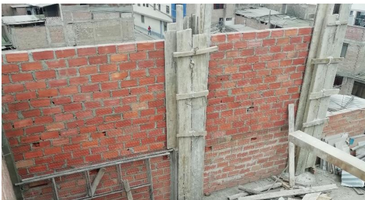
Ilustración 1 Construcción de Albañilería - Fuente propia
