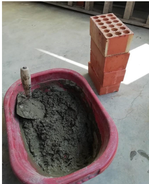
Ilustración 15 Preparación de Mezcla de concreto - Fuente propia
