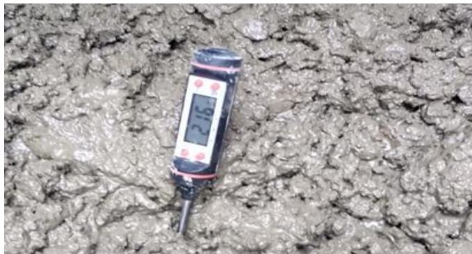
Figura 74. Medición de la temperatura de la mezcla Fuente: Archivo propio
