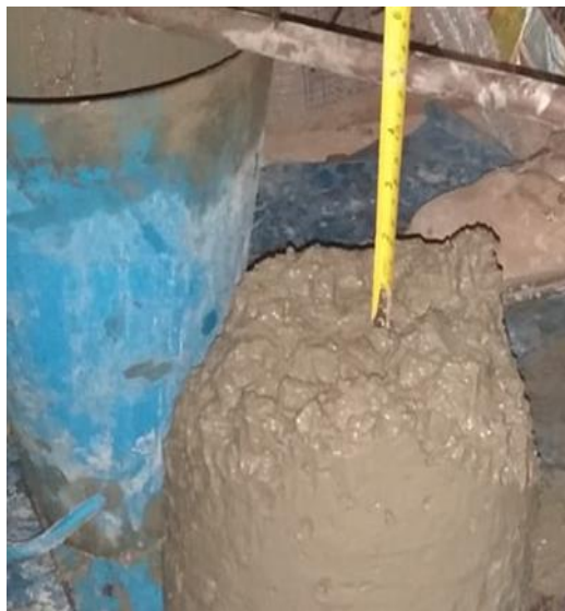
Figura 83. En la figura observamos el slump de 4 3/4" con aditivo 1.00%. Fuente: Archivo propio
