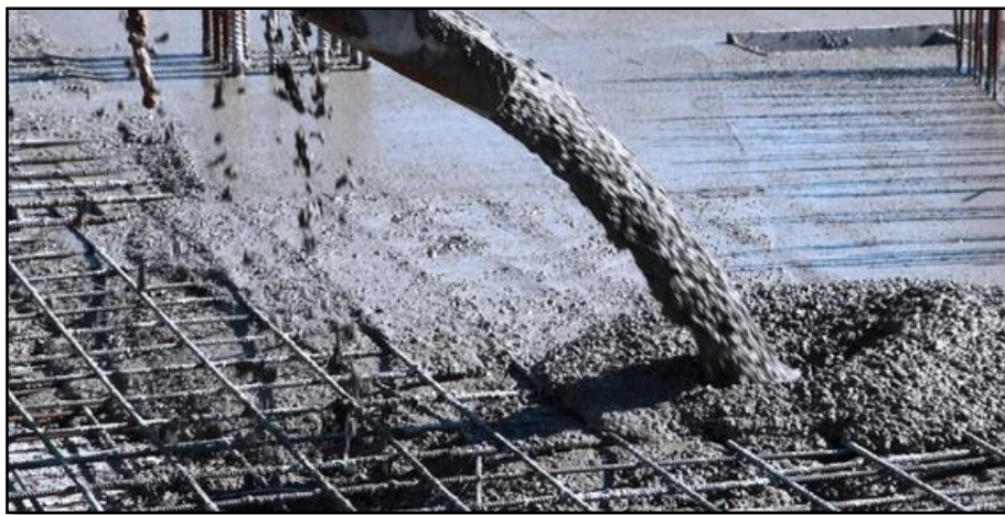
Figura 1. Preparación de concretos para la fabricación de elementos estructurales
