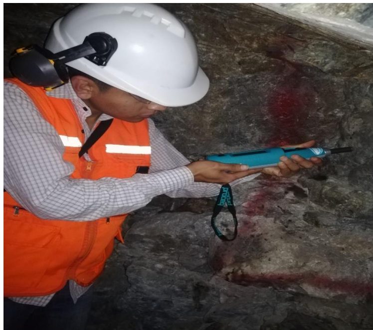
Figura 82. Ensayo de RCU utilizando el Martillo de Schmidt o Esclerómetro
