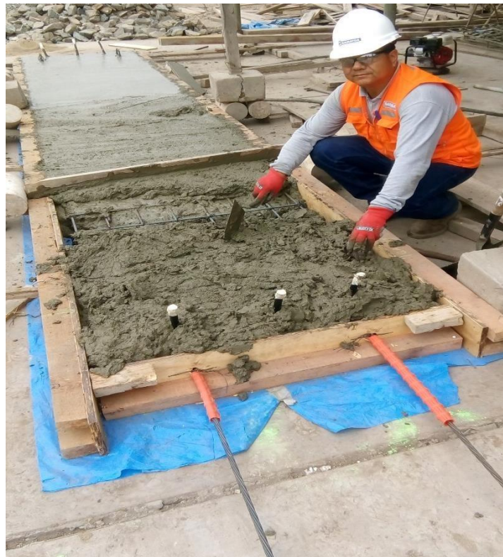
Imagen No. 10: Vaciado de la losa Postensada.
