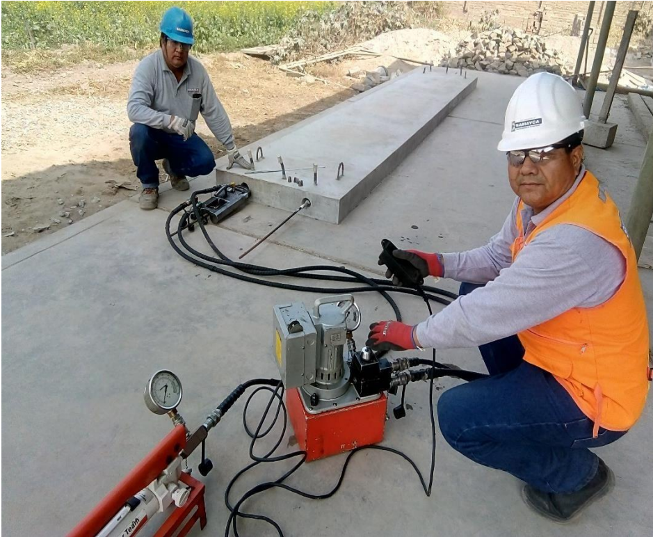
Imagen No. 13: Tensado de la losa postensada.
