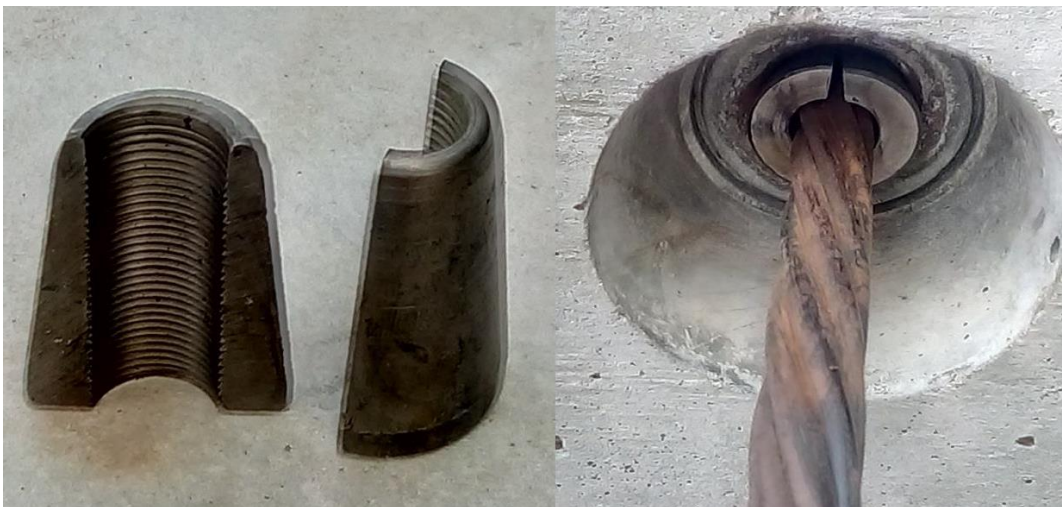
Imagen No. 12: Cuñas para la tensada y colocación de cuñas al cable.
