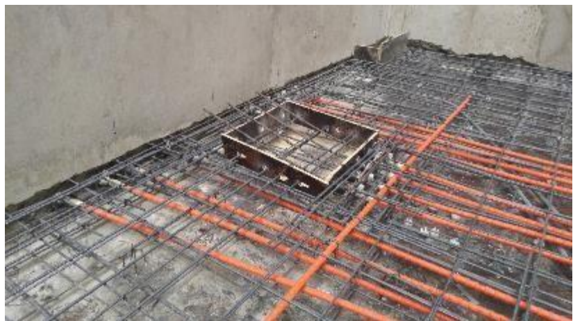
Imagen No. 2. Sistema de Postensado
