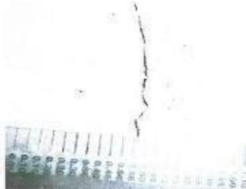
Figura 21. Vista del espesor de la grieta de 0.55mm que se formó en la parte media del espécimen
