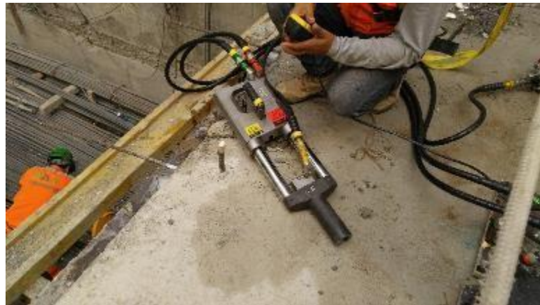
Imagen No. 6. Empleo del gato hidráulico para el tensionamiento de los cables.
