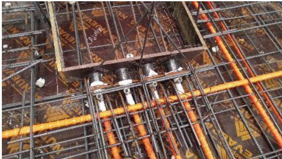
Imagen No. 3, Encofrado por anclajes.
