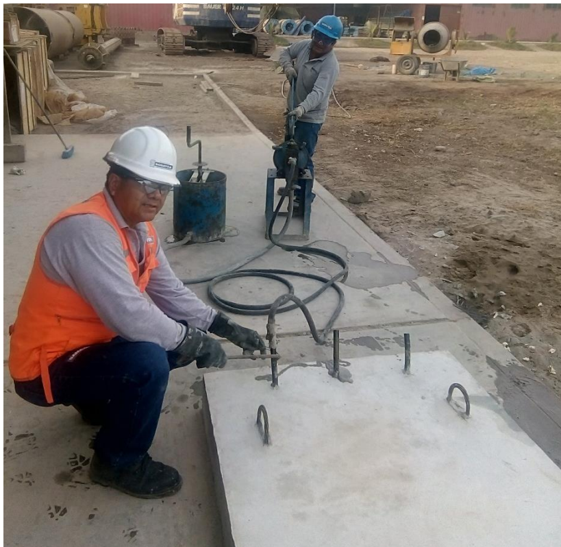
Imagen No. 14: Inyectado de los ductos de la losa.
