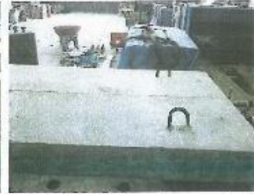
Figura 3. Vista de elementos para el izaje de la losa postensada
