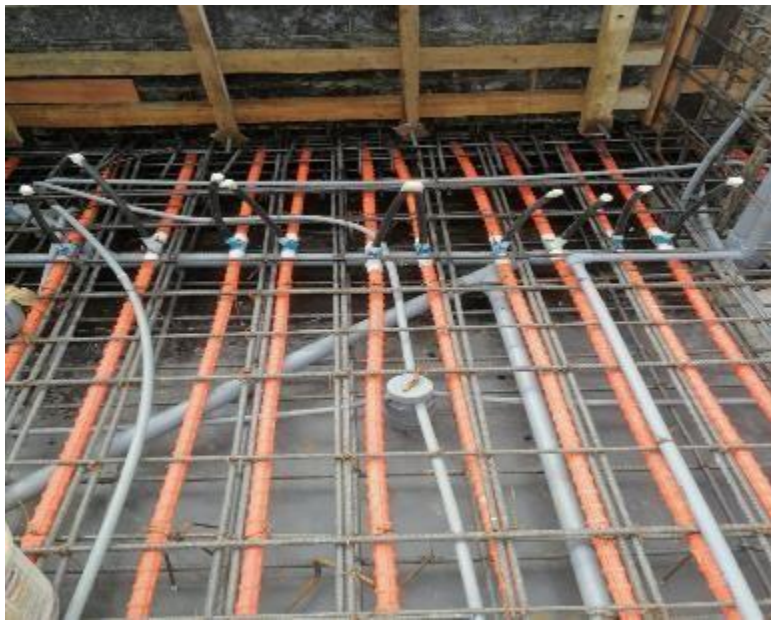
Imagen No. 1. Sistema de Postensado.
