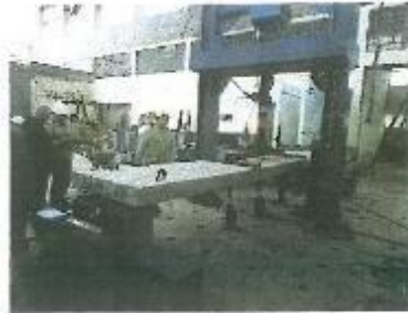
Figura 2 Vista de la losa postensada
