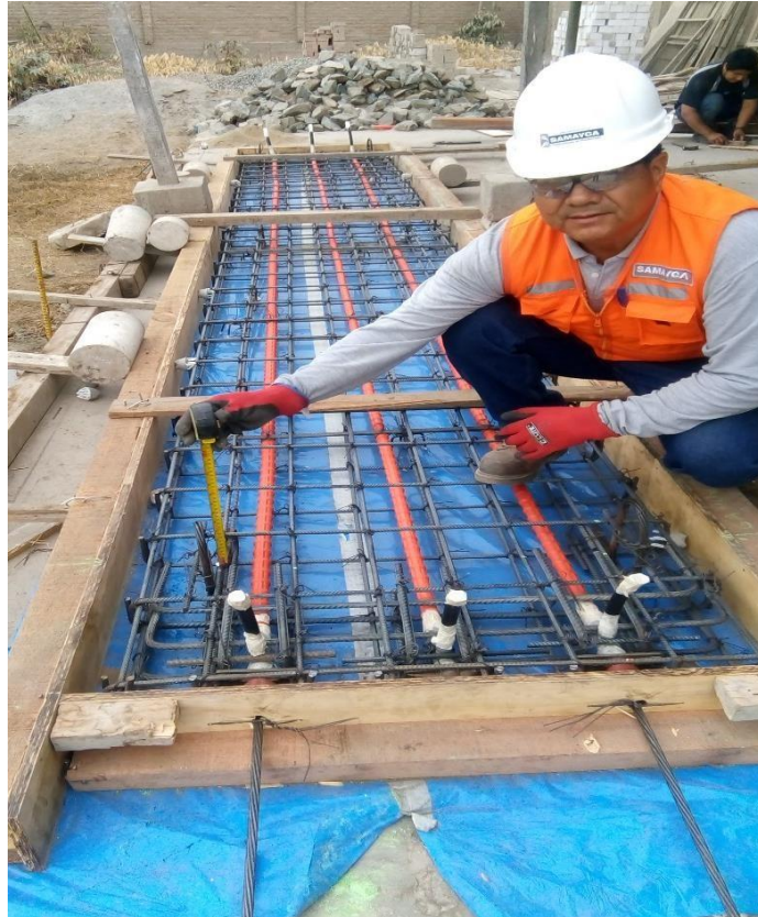
Imagen No. 9: Elaboración de la losa postensada
