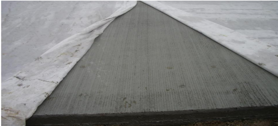
Figura 6: Cobertor de aislante térmico Pavimento texturizado
