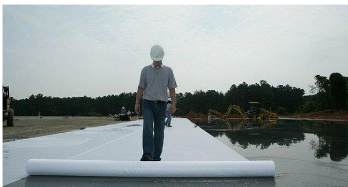
Figura 5: Curado con Cubiertas Aislantes
