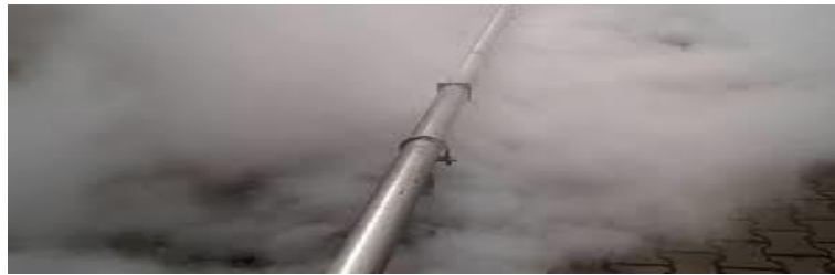
Figura 9: Curado por tuberías a Vapor
