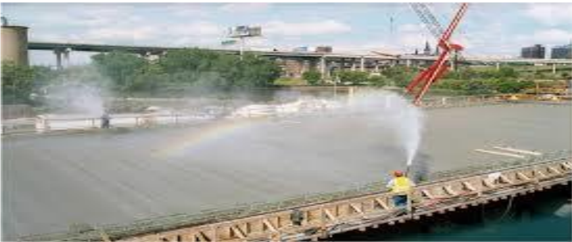
Figura 3: Curado del Concreto lluvia de agua
