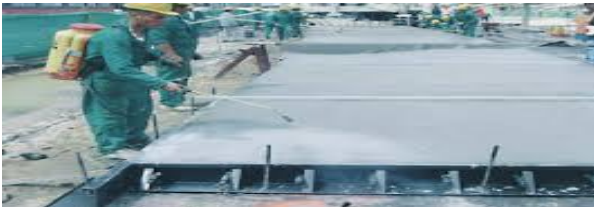
Figura 4: Curado químico fornoedores de Película
