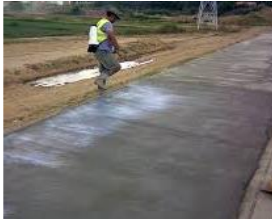
Figura 42: Curado Químico del Pavimento
