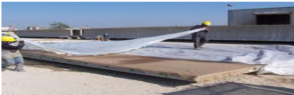
Figura 2: Curado mixto con yute húmedo y Cobertor Plástico
